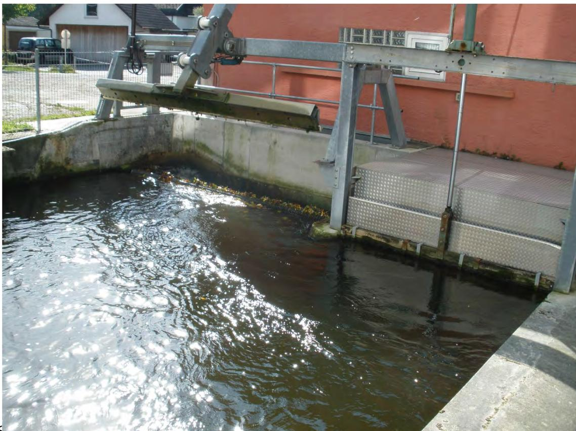
**Bild 27:** Fischundurchlässiges Wehr an Kleinkraftwerk in Langenargen. S. Englmann, 12.06.2013
