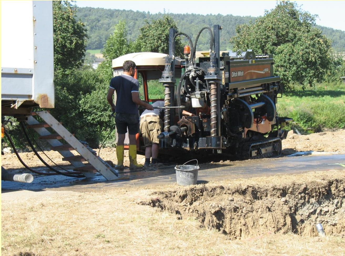
25.08.2016: Spühlbohrung, Leitungsverlegung für Windpark
