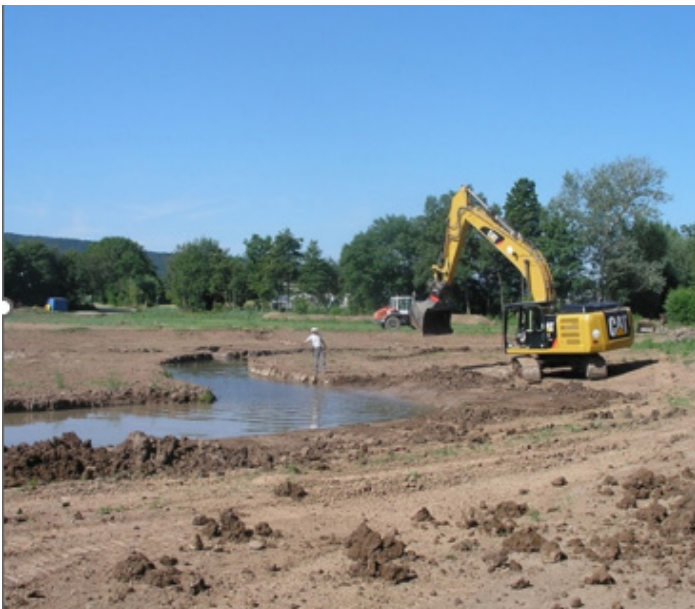
Revitalisierung an der Zaber in der Umsetzung [Büro am Fluss]
