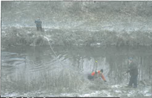
Abb. 1.15: Ermittlung der Wassertiefe mittels Peilstich.
