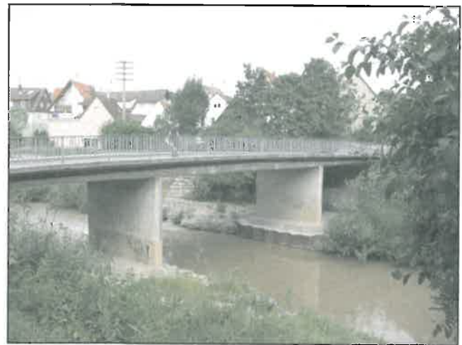
Abb. 1.19: Brücke über die Murr bei Steinheim.
