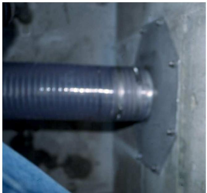
Bild 13: Wandanschluss flexibler Schlauch
