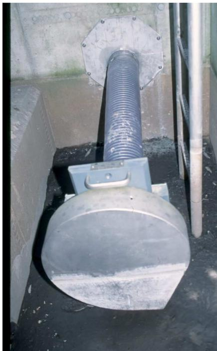
Bild 12: Drosselventil, Wirbelkammer
