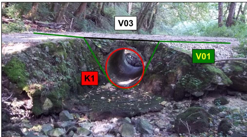
Ein Kreisprofil besteht aus 3 Punkten des Kreises (dadurch ist der Kreis eindeutig beschrieben) und erhalten (gemäß Schlüsselliste) den Punkttyp 60.
