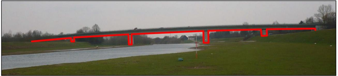
Sofern notwendig können weitere Teilprofile zur Beschreibung des Bauwerkes verwendet werden. Bei der Bezeichnung der Teilprofile im Objekttyp ist darauf zu achten, dass ungerade Zahlen für vom Wasser überströmte Teilprofile und gerade Zahlen für vom Wasser unterströmte Teilprofile verwendet werden.
