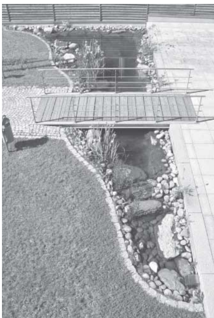
Regenwasserbewirtschaftung am Institut für Seenforschung in Langenargen.
