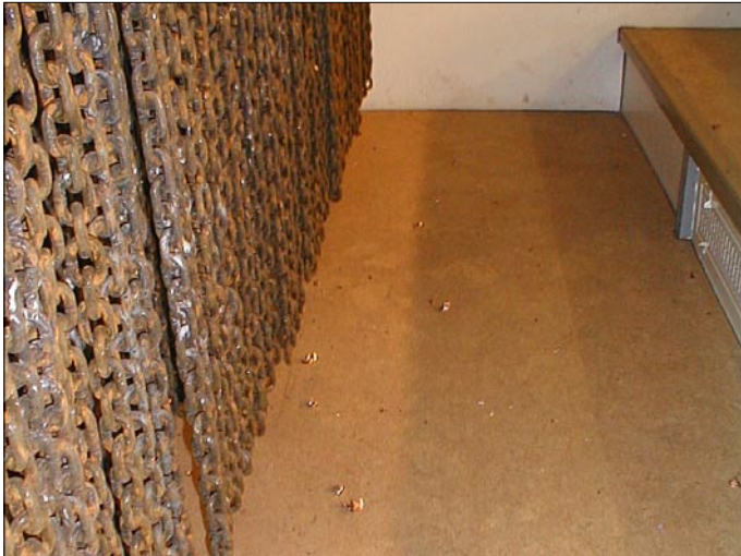
Bild 3: Kettengeschossfangkammer vor Aufnahme des Schießbetriebes
