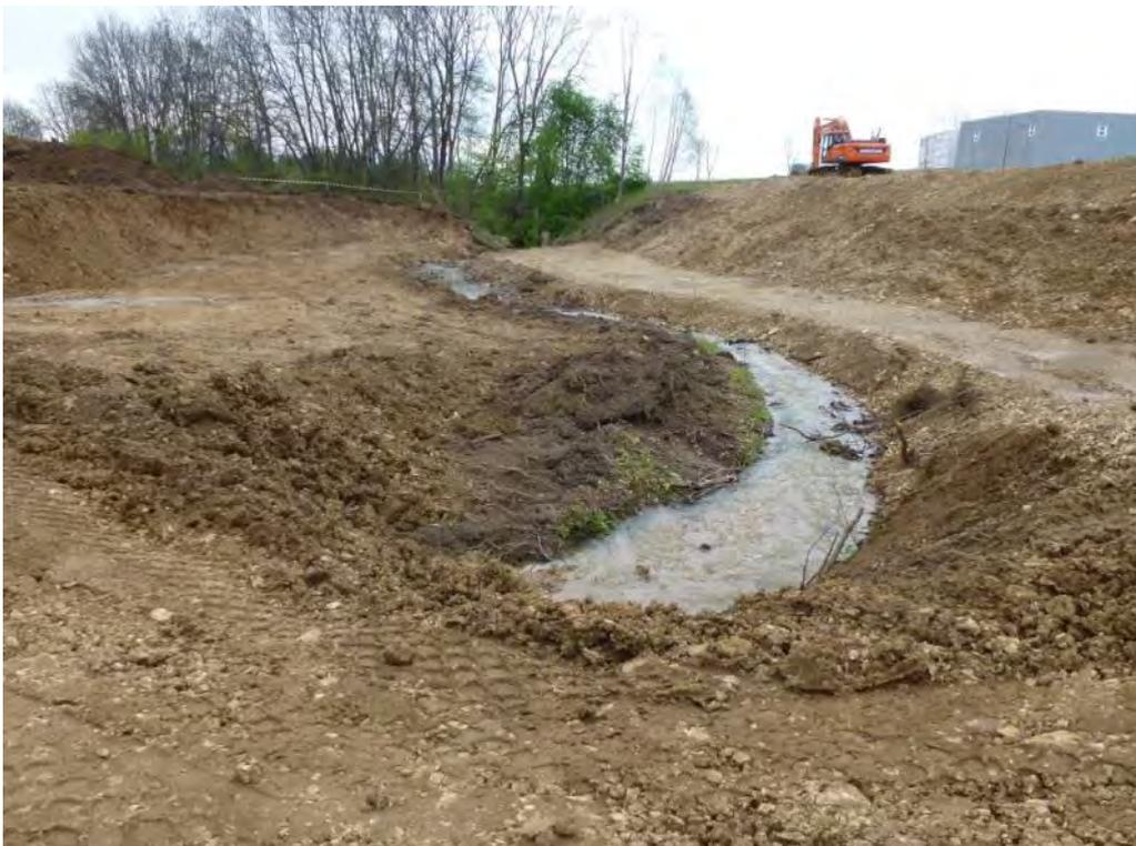
**Bild 72:** Im Buchbach bei Belsen wird ein Hochwasserschutzdamm gebaut. Erfassungseinheit 0168.
