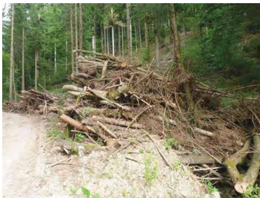
Bild 48: Der Dachsdobel ist durch die Ablagerung von Holz beeinträchtigt. Peter Rudolph, 11.07.20106
