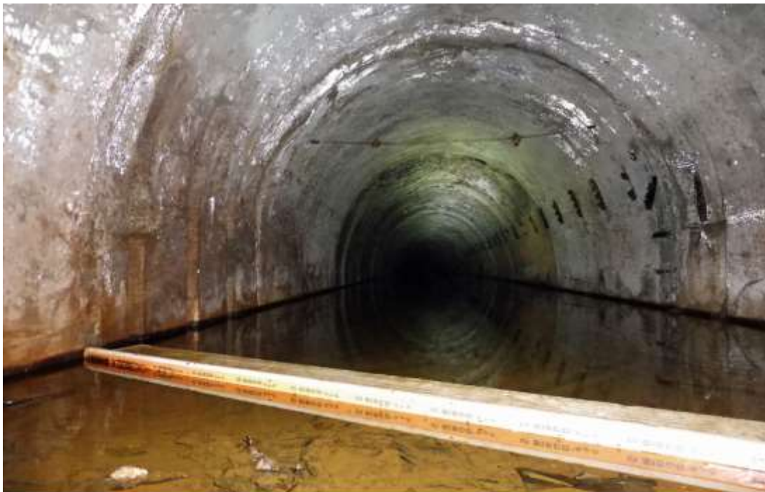
Bild 48: Im Gegensatz zu den natürlichen Höhlen ist der Schutz der künstlichen Stollenanlagen bei Geislingen als Fledermaus-Winterquartiere derzeit nicht sichergestellt, entsprechend sind Maßnahmen erforderlich, die unterem anderem das Einschließen der Tiere bei Verkehrssicherungsmaßnahmen verhindern C. Dietz, 11.03.2018
