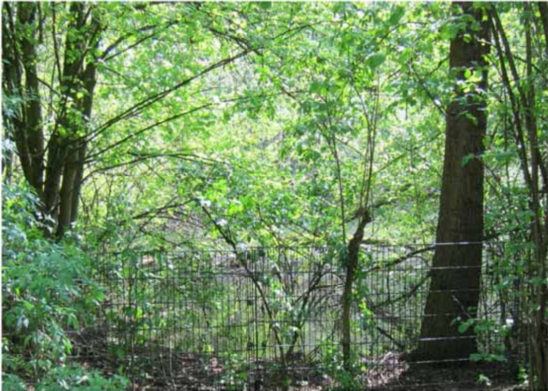
Bild 7: Doppelstabmattenzaun mit unzureichender Bepflanzung der Uferzone und damit fehlende Pufferwirkung.
