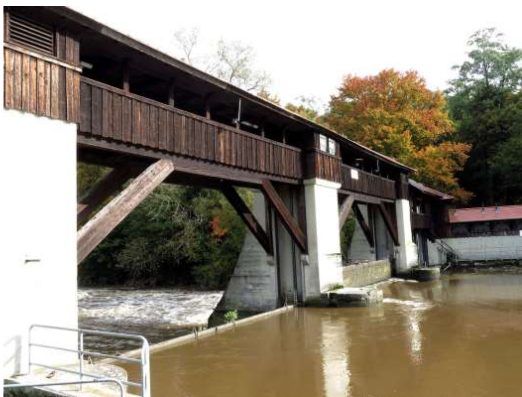
Bild 17: Wanderhindernis Querbauwerk: Wehranlage Mühlhausen der EnBW. Siegfried Demuth, 16.10.2013
