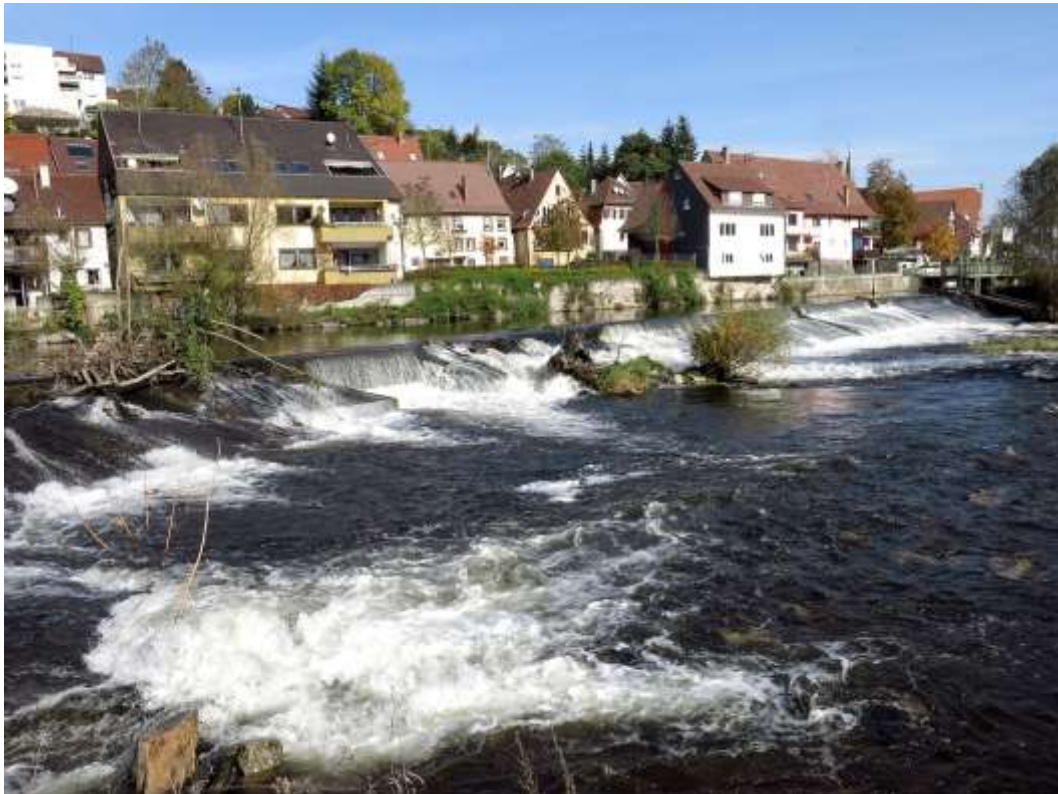
Bild 18: Wanderhindernis Querbauwerk: Wehranlage Lomersheim. Siegfried Demuth, 22.10.2013
