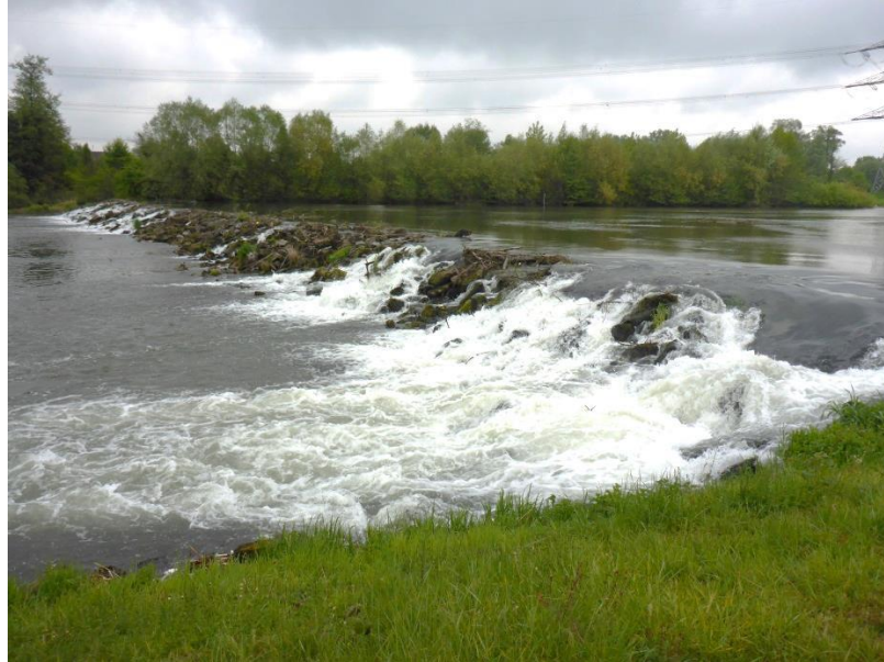
Bild 57: Das Elz-Wehr bei Wittenweier stellt ein Wanderungshindernis auch für leistungsstarke Wanderfische dar. Möglicherweise können nur Lachse ( Salmo salar ) [1106] diesen zu steilen Absturz in der dargestellten Situation überwinden. H. J. TROSCHERL, 26.04.2017
