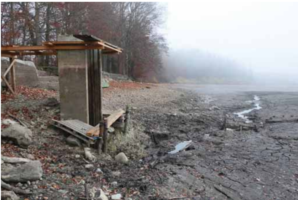
Bild 62: In Erneuerung befindlicher Mönch am Holzmühleweiher Kißlegg. Michael Koltzenburg, 15.11.2018
