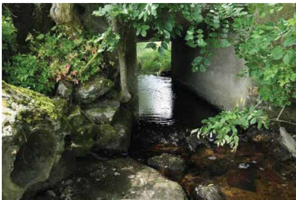
Bild 68: Naturferner Ausbau der Rot und Drainageeinleitung bei Unterrot. Michael Koltzenburg, 17.07.2018
