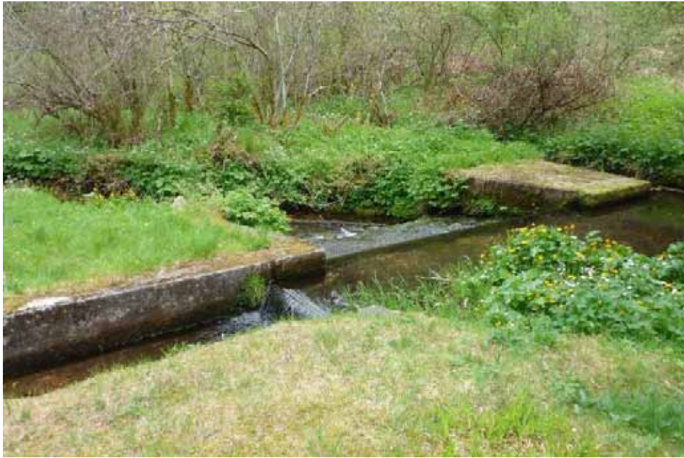
Bild 11 Lebensraumtyp Fließgewässer mit flutender Wasservegetation [3260], Beeinträchtigung durch Uferverbau und Wehr an Kleiner Enz bei Aichelberg Adriane Kempmann, 18.05.2017
