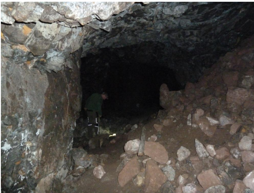
Bild 90: Im Innern des Lützelbergstollens bei der Quartierkontrolle. Andreas Zapp, 21.09.2017, Lützelberg westlich Sasbach, EE 27911341310008
