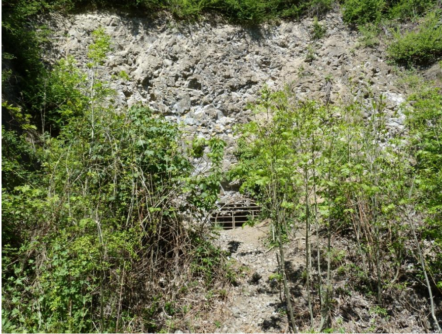
Bild 89: Vergitterter Stolleneingang am Lützelberg, direkt an der K 5144. Der Stollen dient u.a. dem Großen Mausohr [1324] als Winterquartier. Andreas Zapp, 30.04.2017, K 5144 westlich Sasbach
