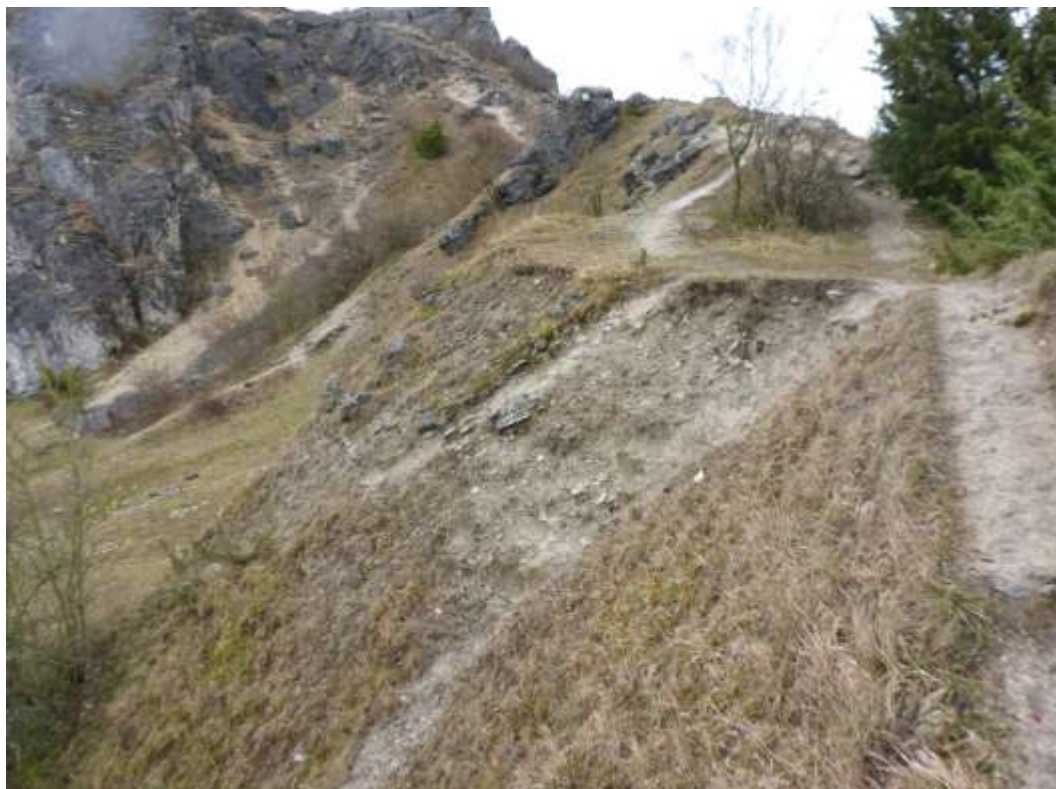
Bild 43: Entlang des Wanderwegs „Löwenpfade“ gibt es zahlreiche Trittschäden M. Dieterich, 25.02.2020
