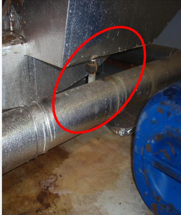
**Problem:** Verlegung der Entwässerungsleitung in die Abschlammleitung.
