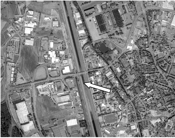
Abb.15 Durch massiven Ausbau vollständig veränderter Gewässerabschnitt (Kinzig)
