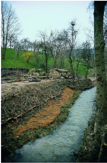
Abb.24 Ufersicherung durch ingenieur-biologische Bauweisen
