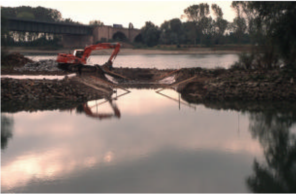
Abb.19 Schaffung von Durchlässen zur Reaktivierung von Altarmen und Überflutungsräumen (Rhein)
