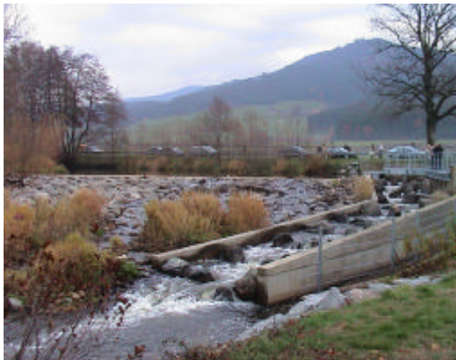
Abb.21 Schaffung der Durchgängigkeit durch den Bau eines Umgehungsgerinnes (Elz)
