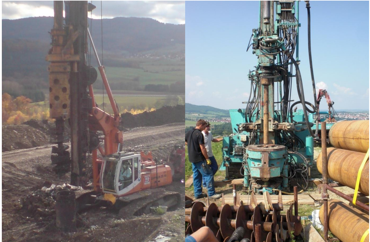
ABBILDUNG 29: LINKS: BOHRSTAFFEL I - KETTENBAGGER MIT BOHRAUFSATZ | RECHTS: BOHRSTAFFEL II – SELBSTFAHRENDES KLEINBOHRGERÄT
