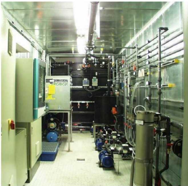
Abbildung 2: BIOMEMBRAT® Membranbioreaktor
