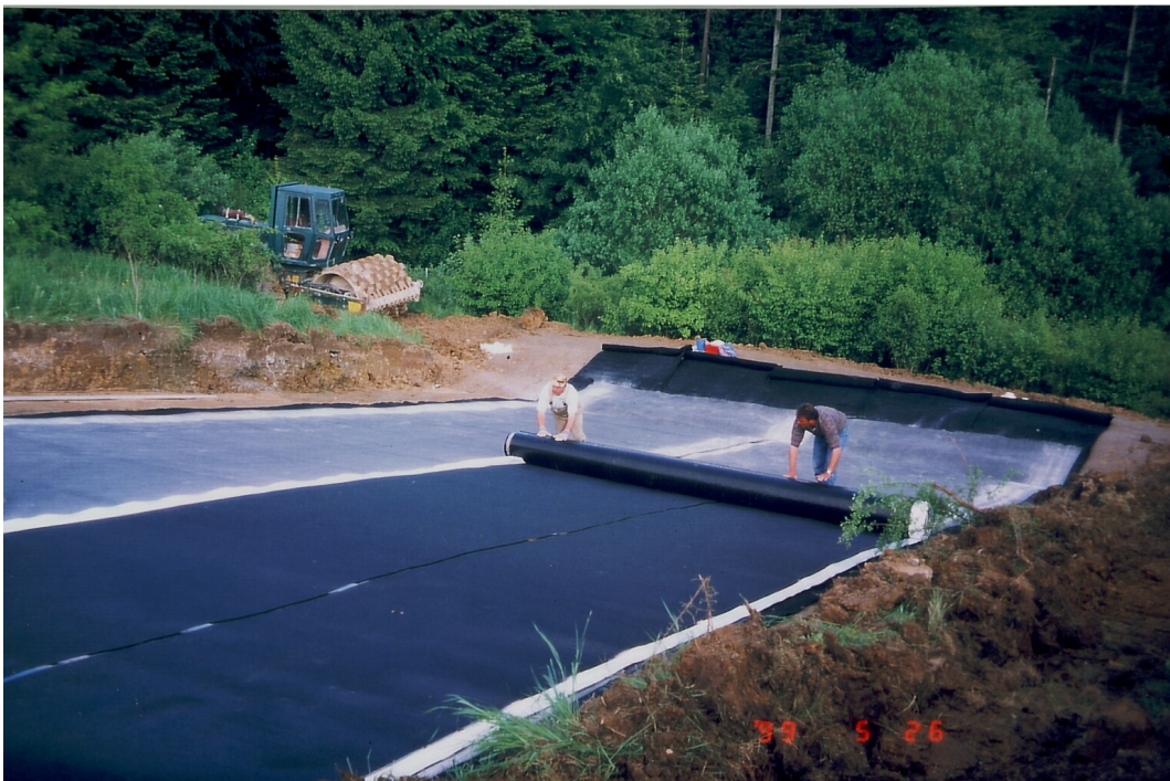
Foto 2: Verlegung der Kunststoffdichtungsbahn (KDB) auf der Bentonitmatte
