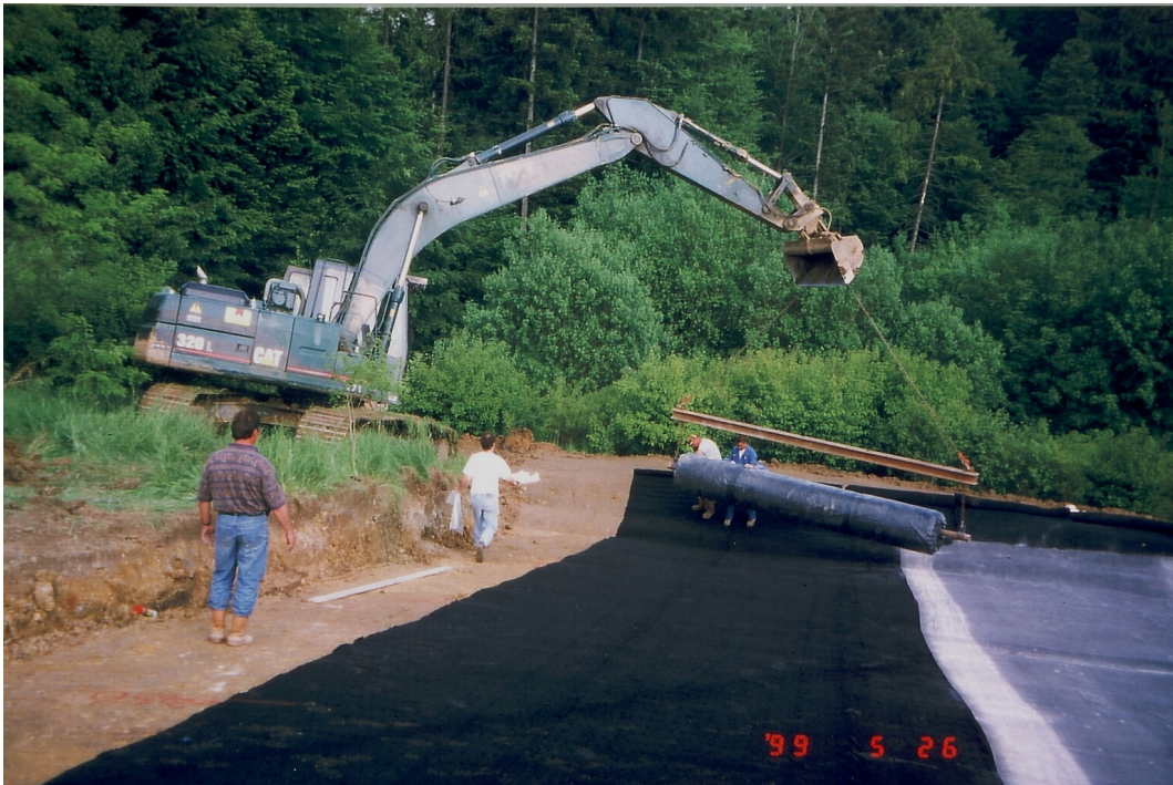
Foto 1: Verlegung der Bentonitmatte auf der Gasdrainmatte
