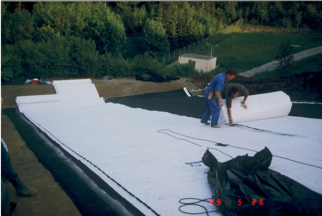
Foto 3: Verlegung der Entwässerungsdrainmatte oberhalb der KDB
