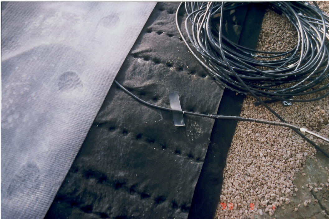
Foto 6: Installation des Dichtungskontrollsystems
