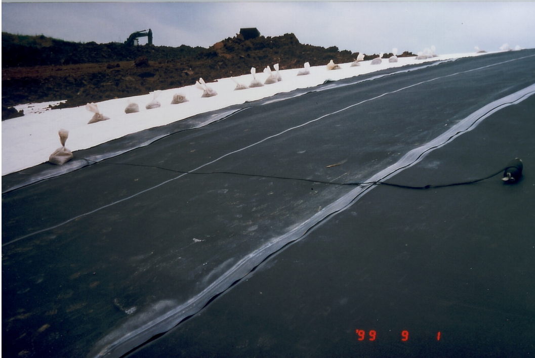
Foto 5: Ausführung des alternativen Dichtsystems im Böschungsbereich
