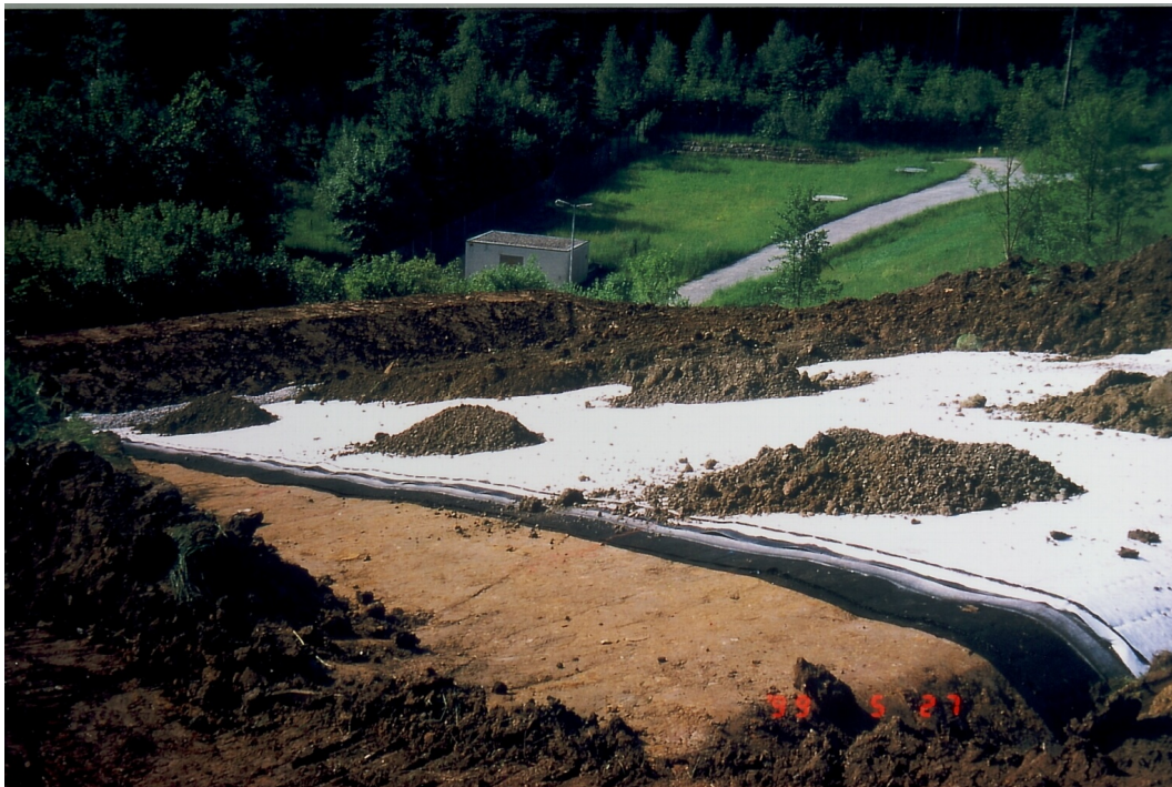
Foto 4: Sicherung der Entwässerungsdrainmatte mit Rekultivierungsboden
