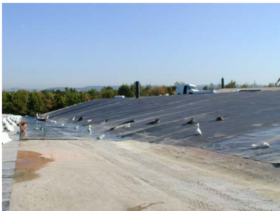
Bild links: Verlegung der Kunststoffdichtungsbahn
