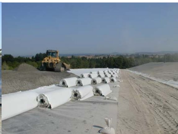
Bild rechts: Einbau der Kapillarsperre mit Kapillarblockbahn und Kapillarsand
