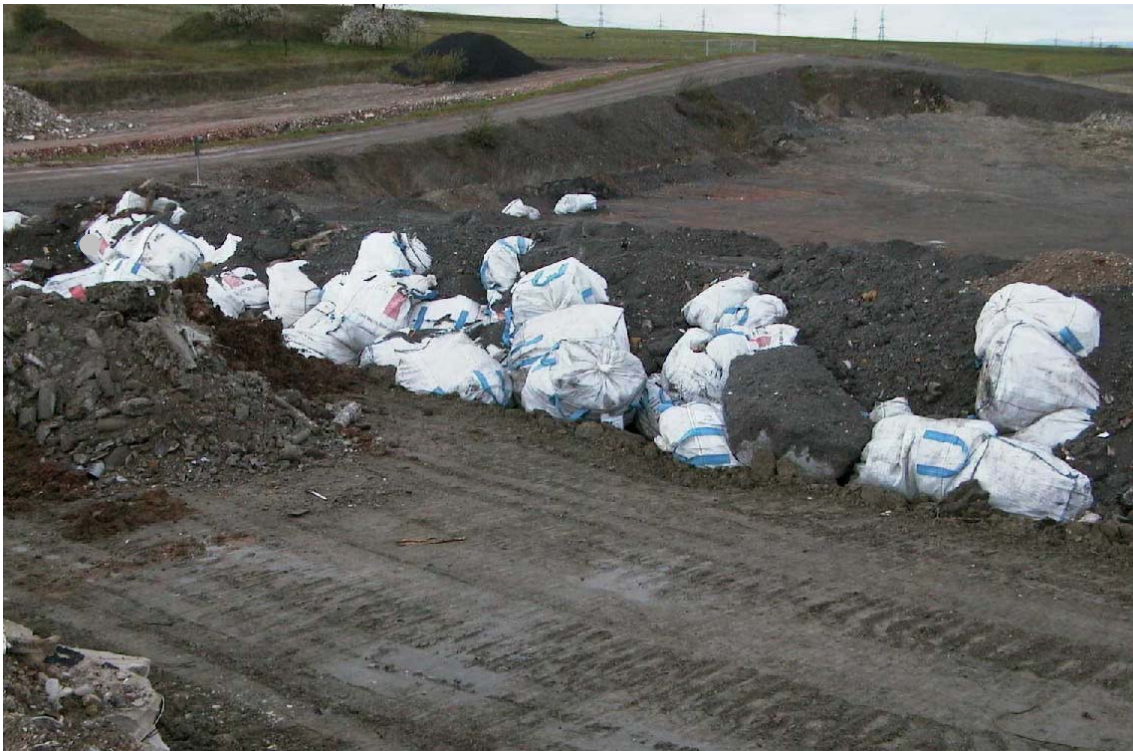
Abb. 13: Schlacke als Deponiebaustoff für den Einbau von Big-Bags und für den Wegebau
