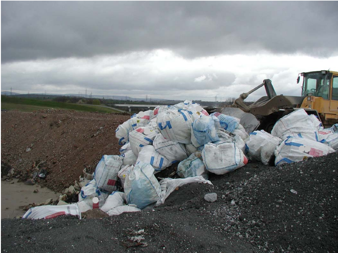
Abb. 12: Schlacke als Verfüllmaterial für den Einbau von Big-Bags
