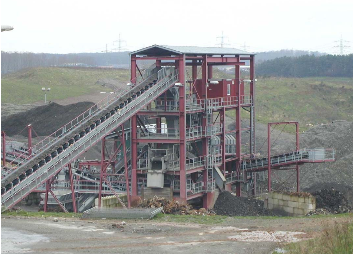
Abb. 18: Schlackeaufbereitung mit vertikaler Anordnung der Aufbereitungsschritte
