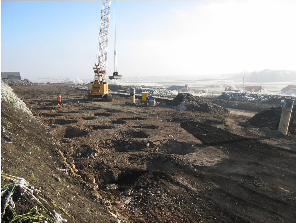
Abb. 6: Verdichtungsbereich mit Darstellung der Schlagtrichter
