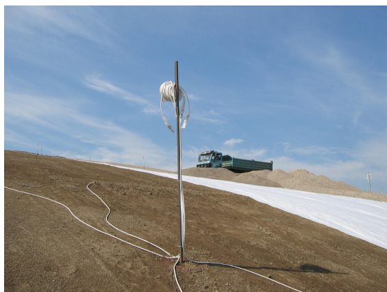
Bild 7: Kabelbündel der verwahrten Anschlüsse
