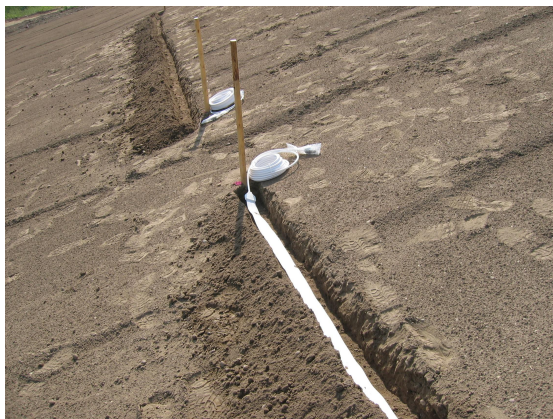
Bild 6: Verlegung der TAUPE-Sensoren
