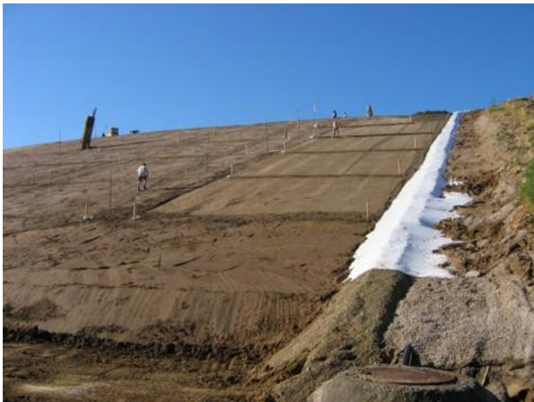
Bild 5.8: Verlegen der TAUPE-Sensoren in parallelen Gräben senkrecht zur Hangneigung
