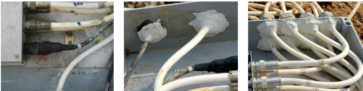
Bild 3.6: Isolierung des Steuerkabelanschlusses mit selbstverklebendem Isolierband und zusätzliche Abdichtung der Kabeldurchführungen (PG-Verschraubungen) mit Knetmasse in den ausgetauschten/reparierten Mux.
