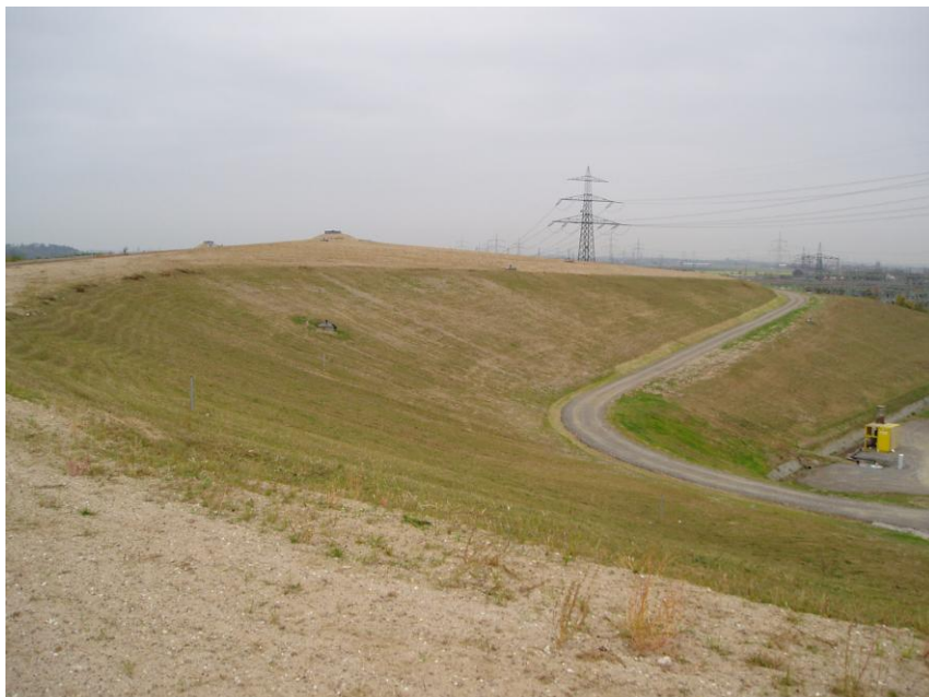
Bild 2: Nahezu gleicher Standort nach Fertigstellung der Maßnahme
