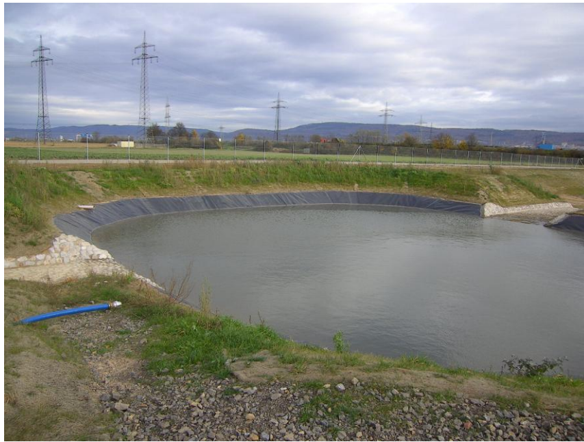
Bild 11: ADAC-Speicherbecken nach Inbetriebnahme - im Vordergrund Schlauchanschluss für Saugpumpe
