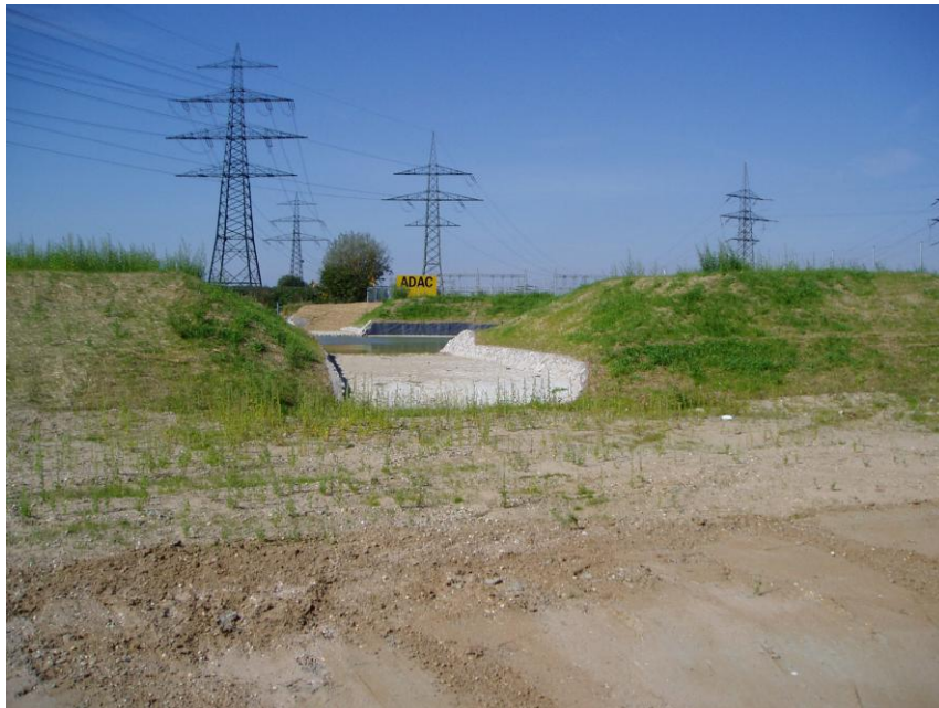
Bild 14: Überlauf vom ADAC-Speicherbeckens ins Versickerungsbecken III
