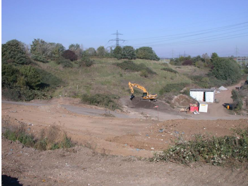
Bild 1: Ursprüngliche Zufahrt vor der Sicherung der Deponie
