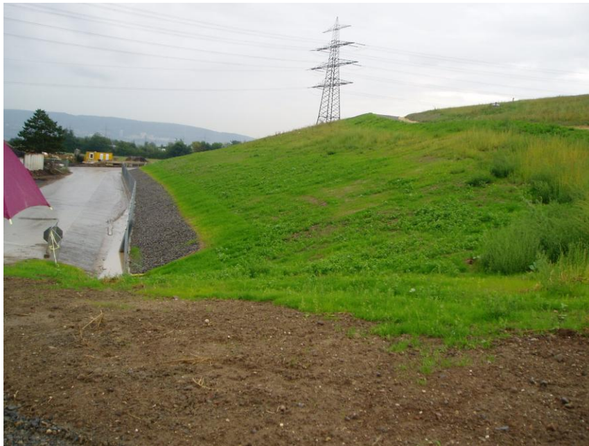
Bild 5: fertiggestellte und begrünte Nordböschung im Ostteil der Deponie
