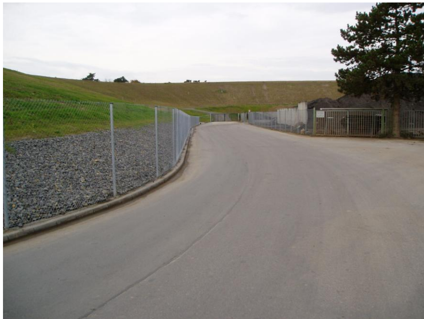
Bild 4: Neuer Eingangsbereich nach der Fertigstellung im Herbst 2008
