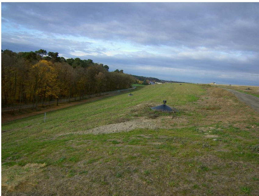
Bild 20: Blick auf die Südböschung nach der 1. Mahd
