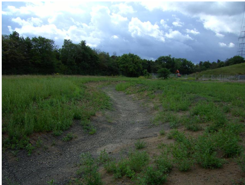
Bild 12: Befestigte Oberflächenentwässerungsmulde vor dem Einlauf ins ADAC-Speicherbecken
