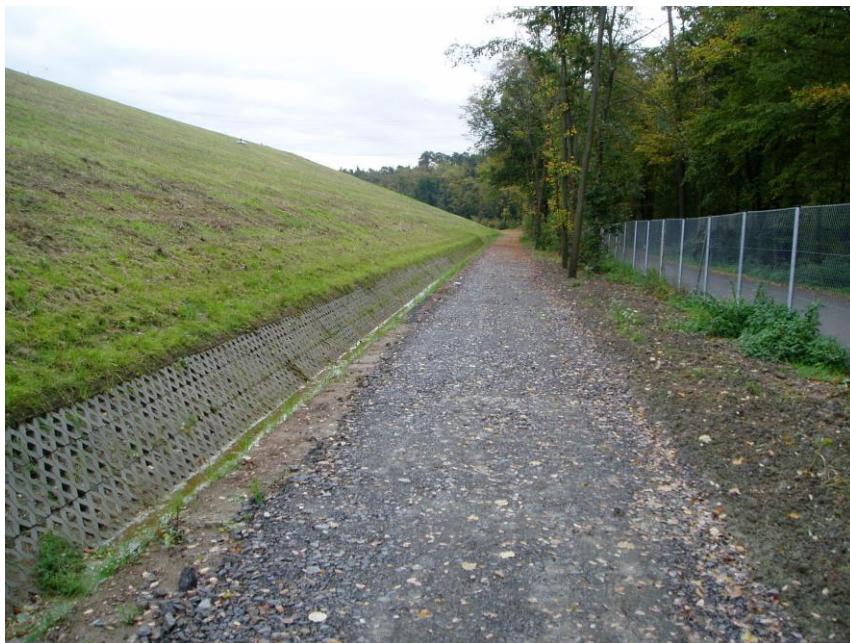
Bild 16: Südböschung im Westteil mit neuem Randweg am Böschungsfuß
