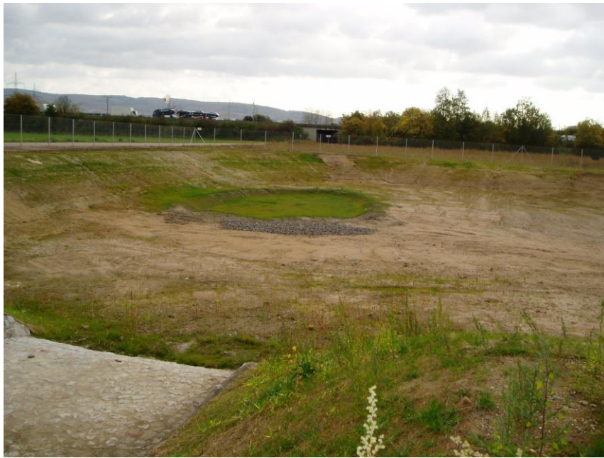
Bild 21: Versickerungsbecken II mit Vertiefung für offene Wasserfläche (siehe Grünfläche)
