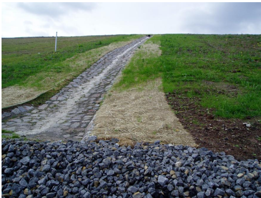
Bild 6: Befestigte Entwässerungsmulde zur Ableitung der Oberflächenwasser am Nordrand
