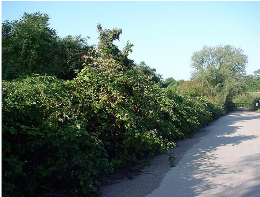
Bild 3: Deponiezufahrt mit Tor im Frühjahr 2005 vor Beginn der Baumaßnahme
