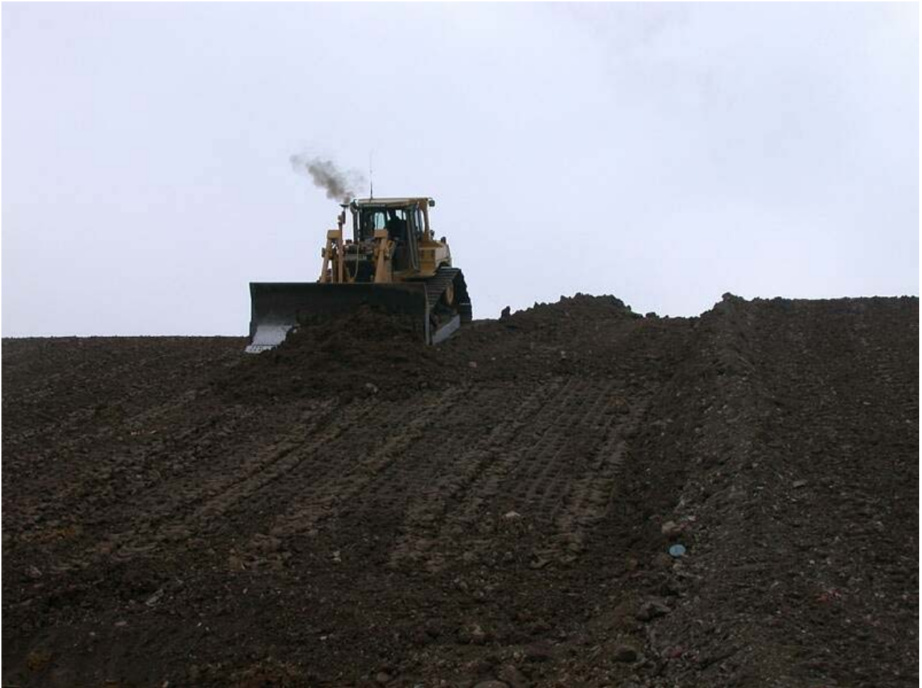
Bild 10: Lagenweiser Einbau von Profilierungsmateril
