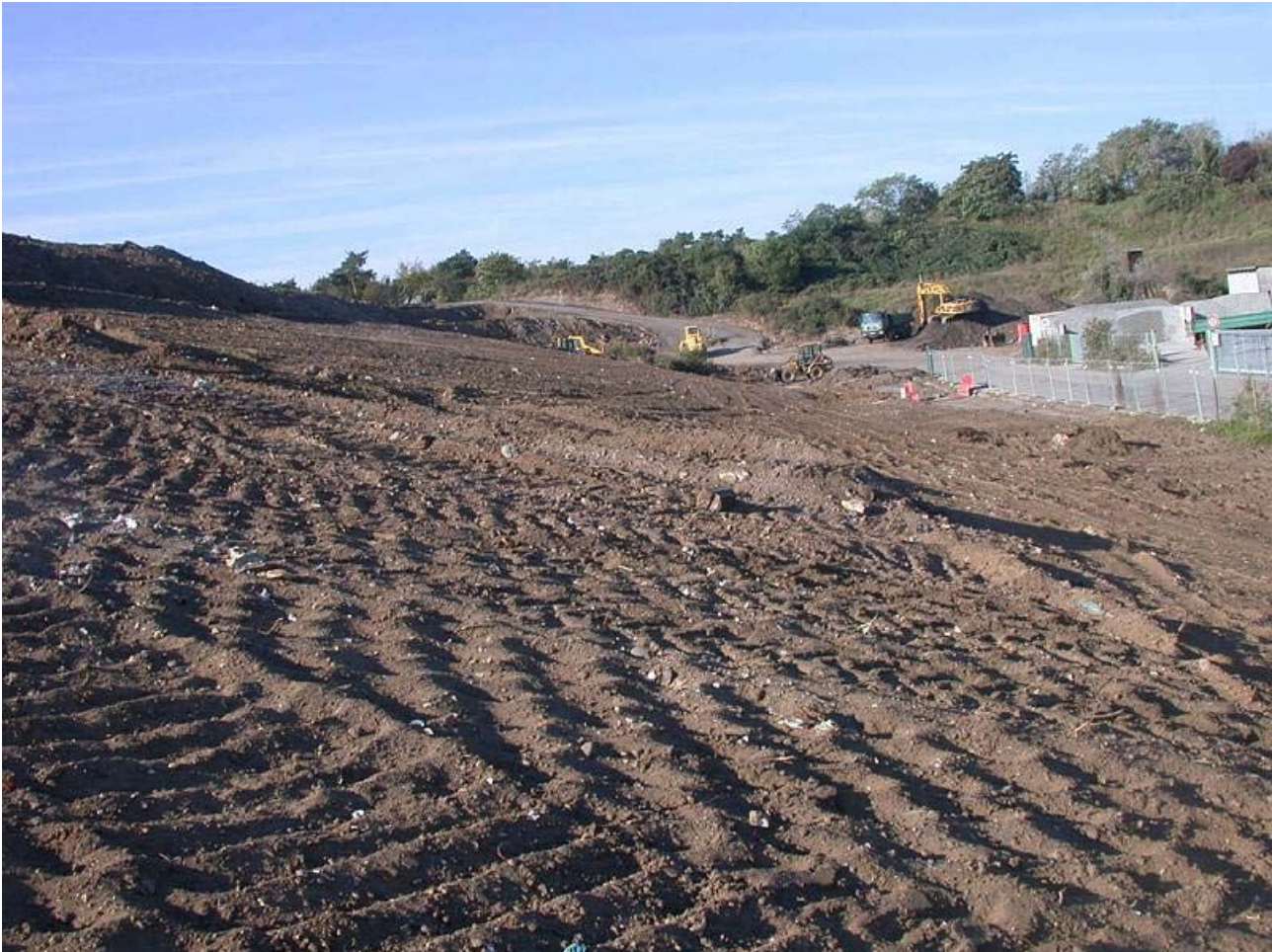
Bild 6: Nordböschung der Deponie im Ostteil
