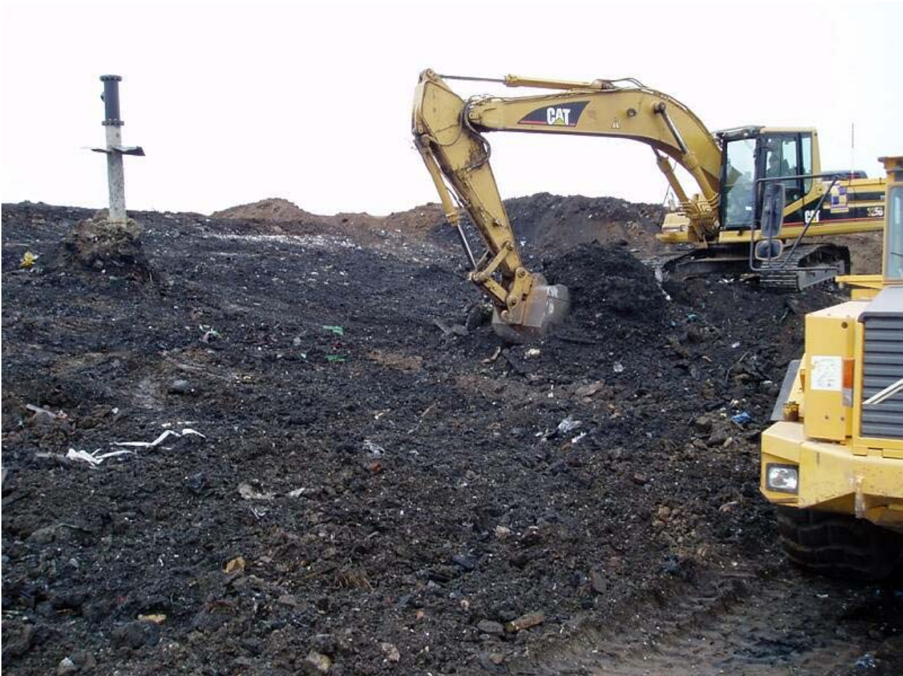
Bild 15: Abfallumlagerung am Südrand oberhalb der Auffahrt
