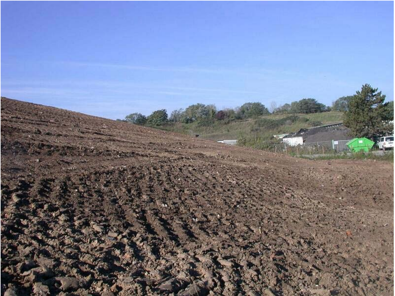
Bild 7: Nordböschung im Ostteil
