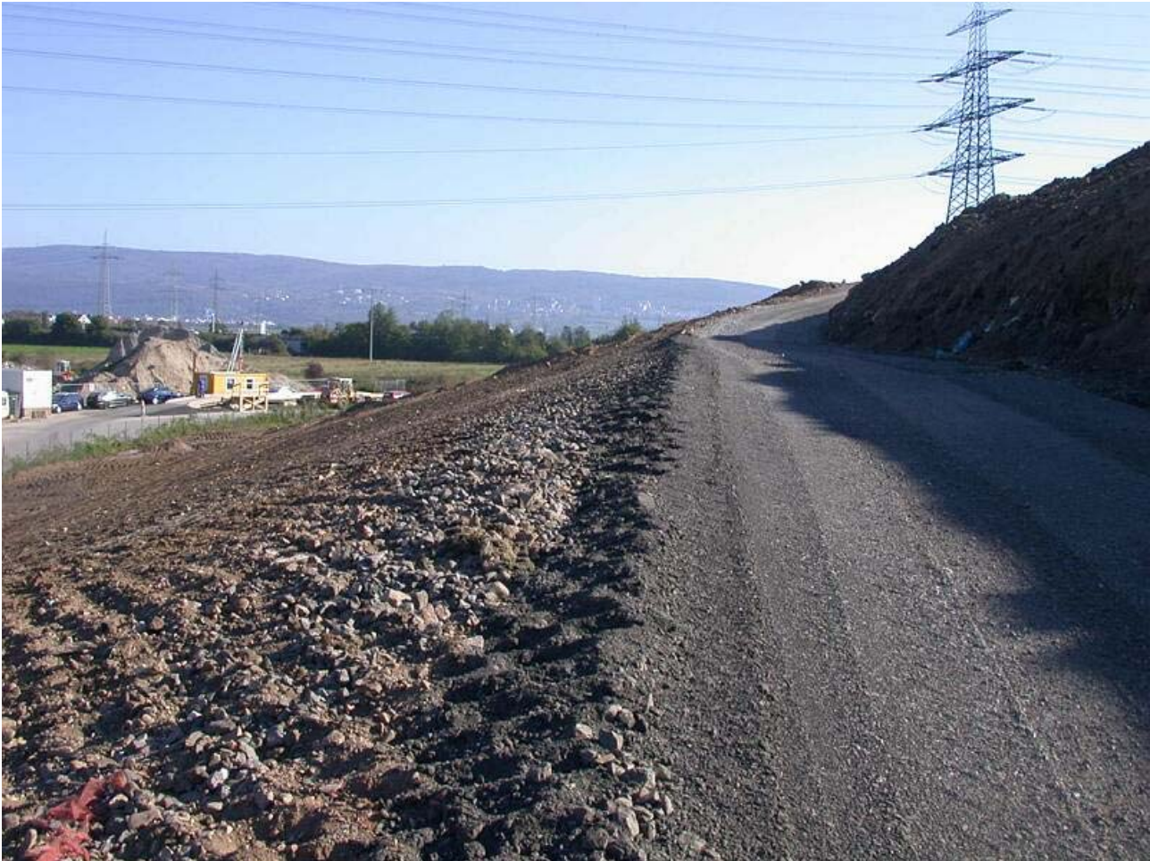
Bild 8: neue Deponieauffahrt im Ostteil nach Fertigstellung
