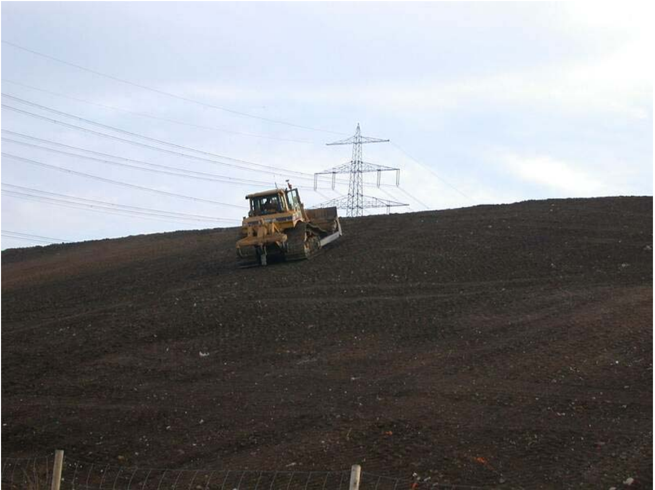
Bild 11: GPS-Raupe im Einsatz
