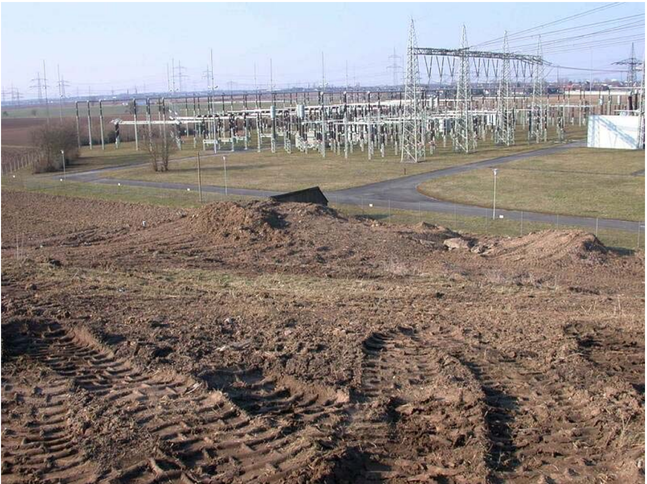
Bild 12: Blick zum EnBW-Gelände Richtung Nordwesten nach erfolgter Rodung
