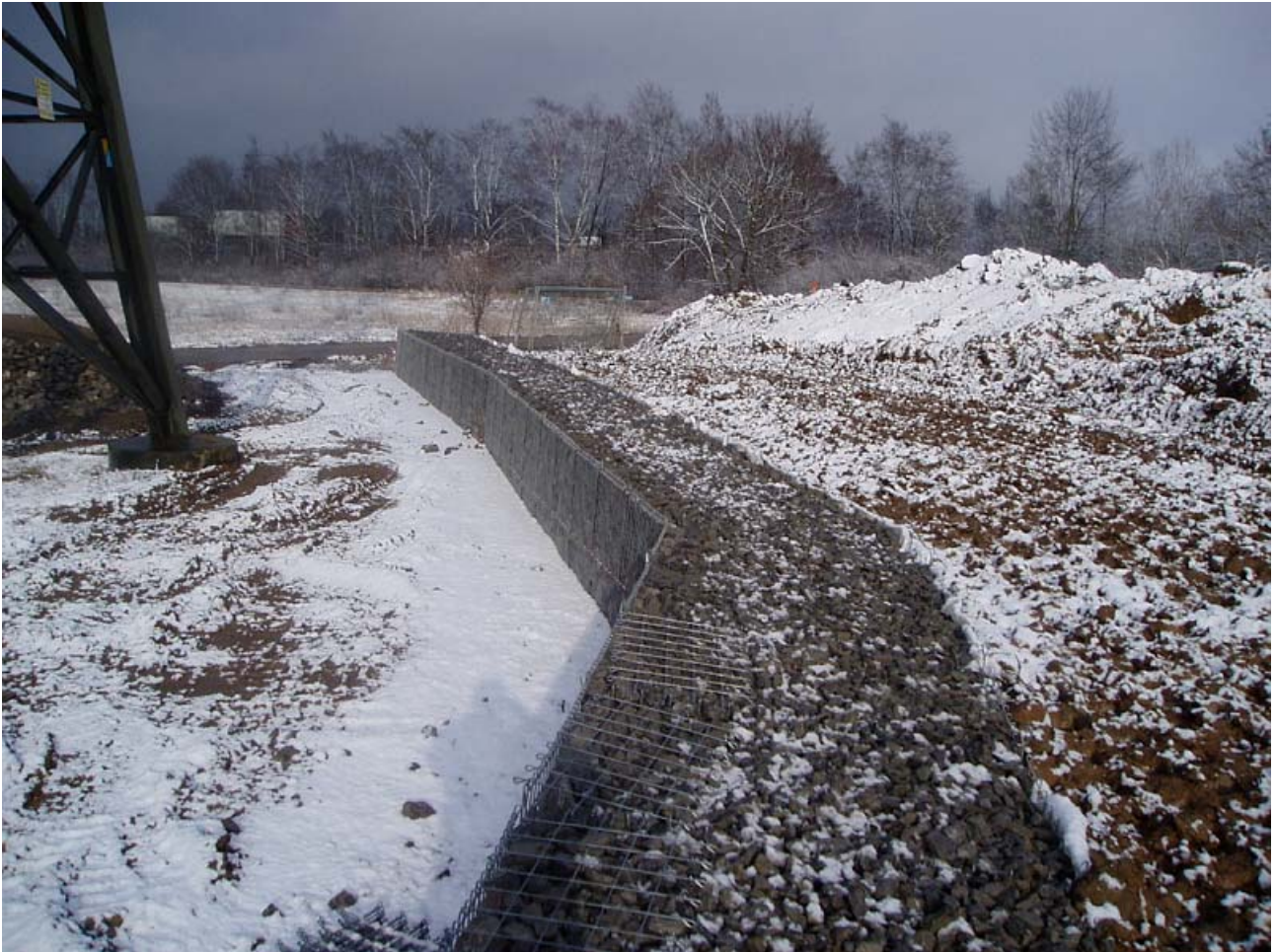
Bild 18: unterste Lage der Gabionenwand neben dem Hochspannungsmast
