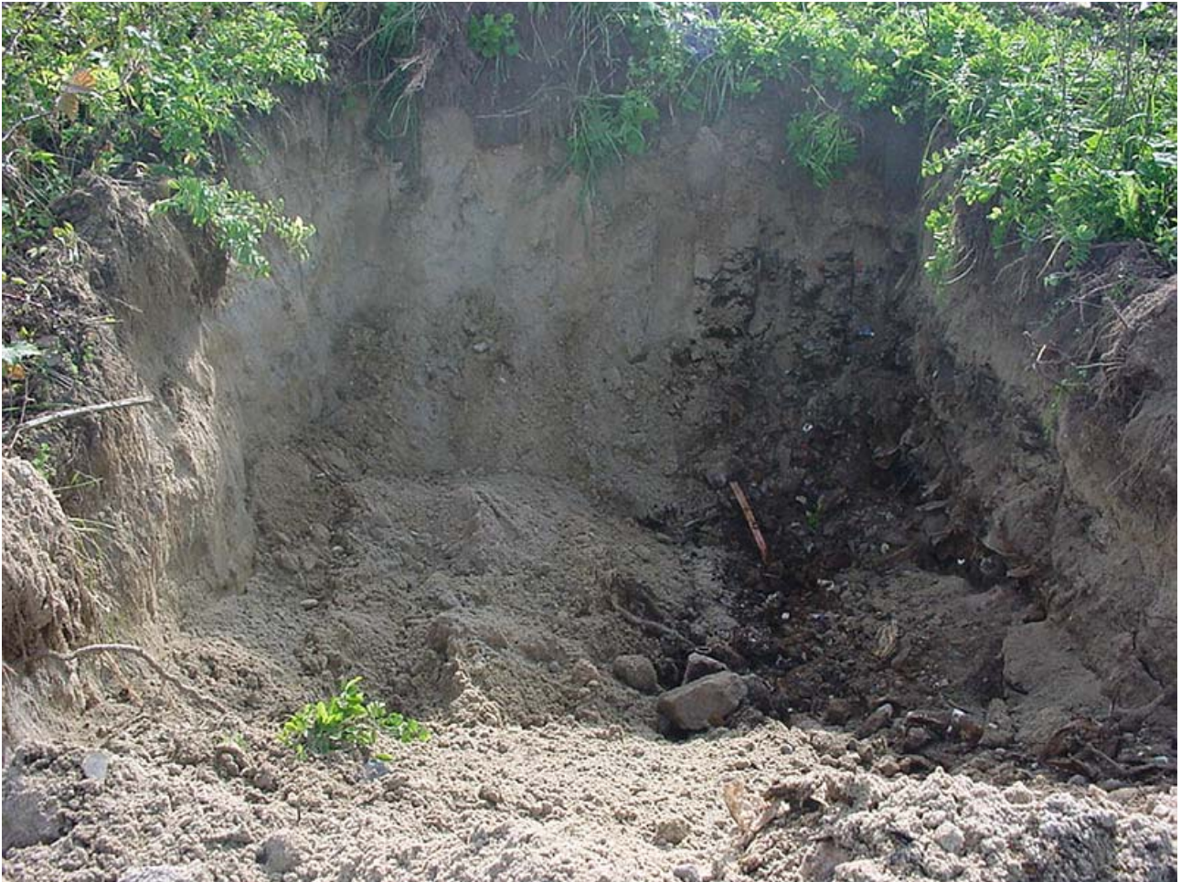
Bild 17: Suchschlitz für Gründung Gabionenwand im Ostteil beim Hochspannungsmast
