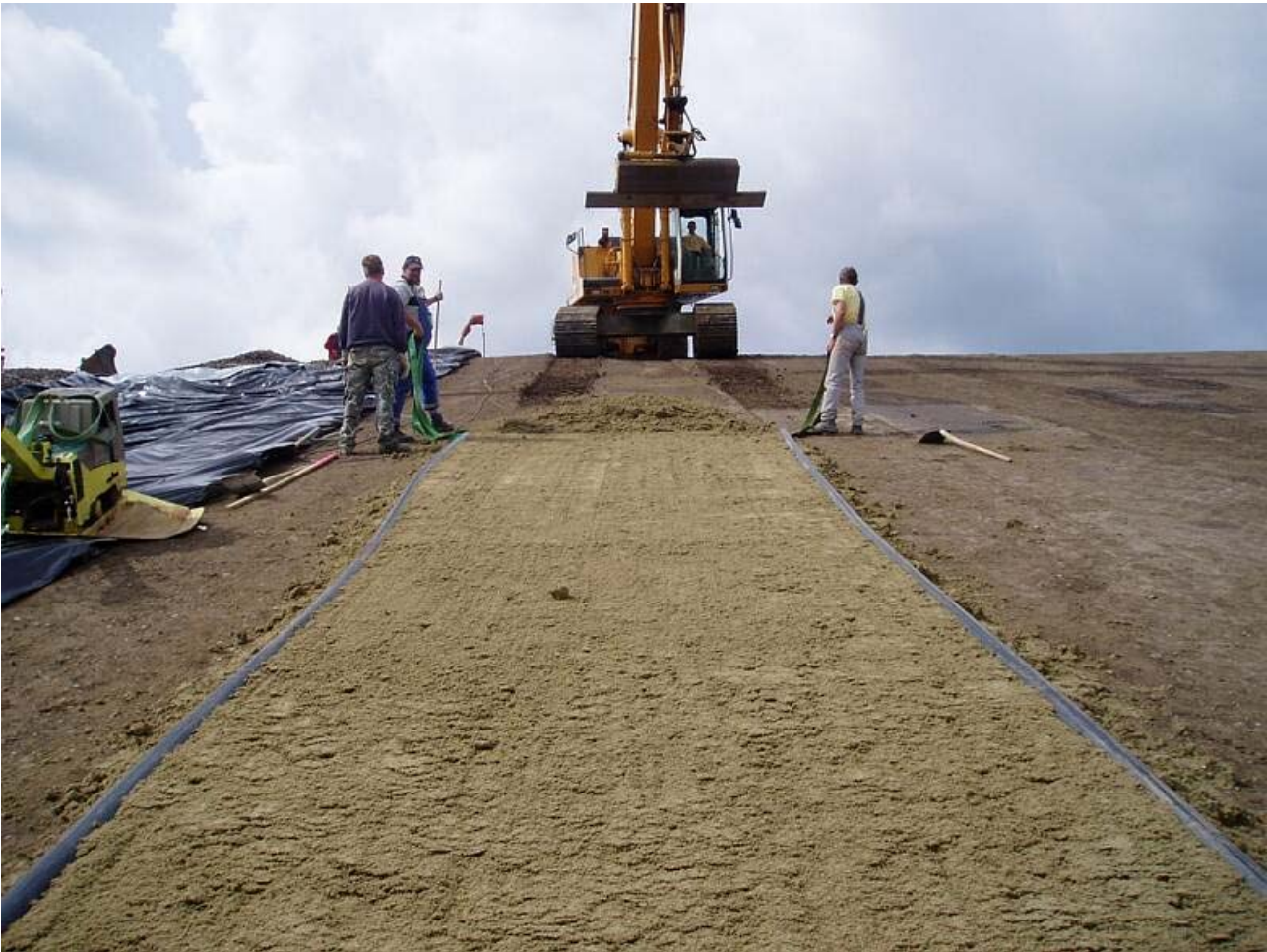
Bild 6: Einbau Trisoplast im Bereich der Böschung
