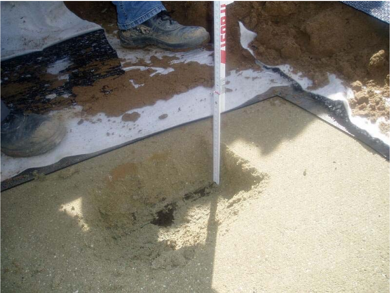
Bild 21: Nachweis Schichtstärke der freigelegten Trisoplastabdichtung
