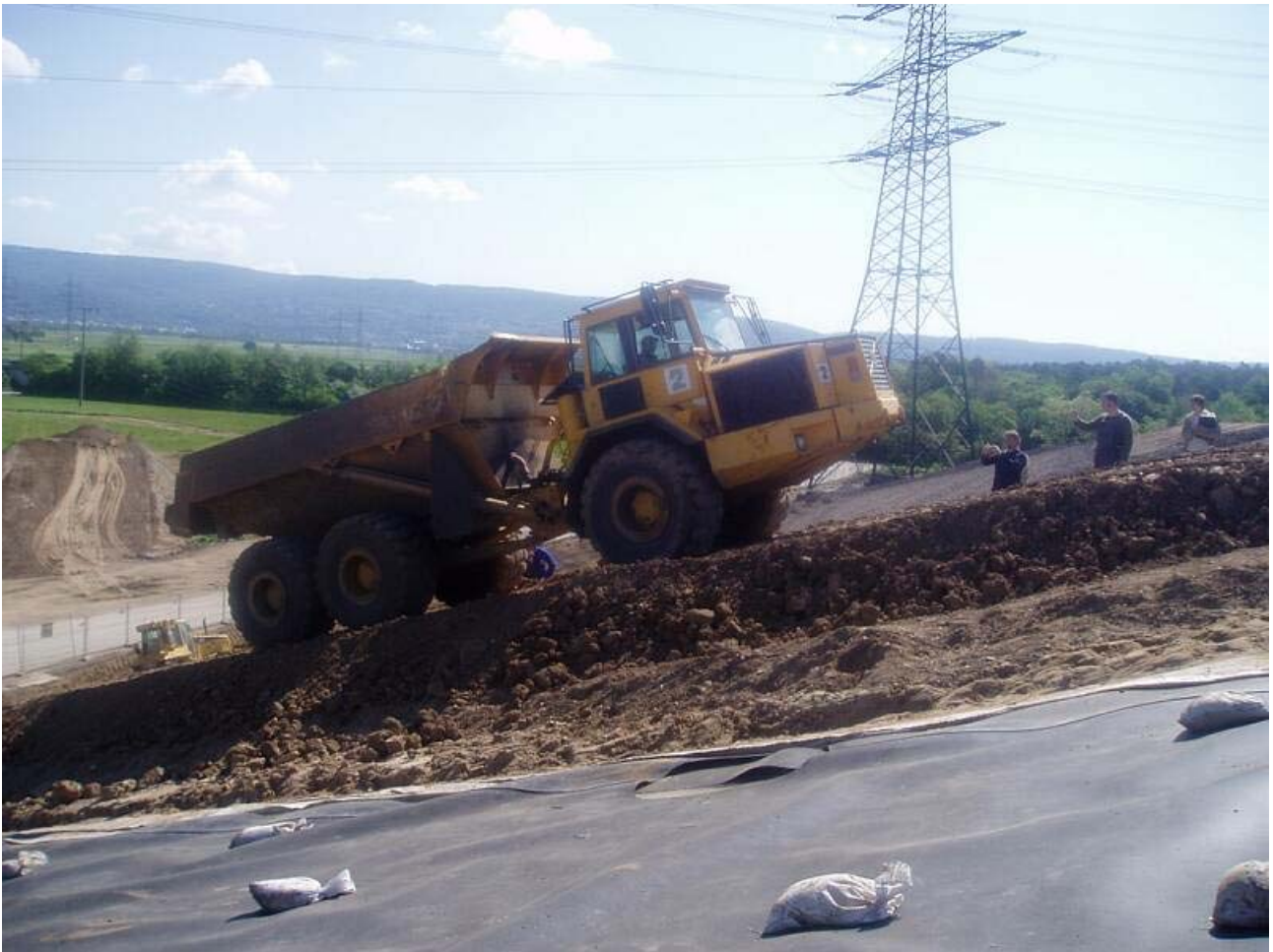
Bild 16: Befahrung der Testfeldoberfläche mit dem beladenen Dumper
