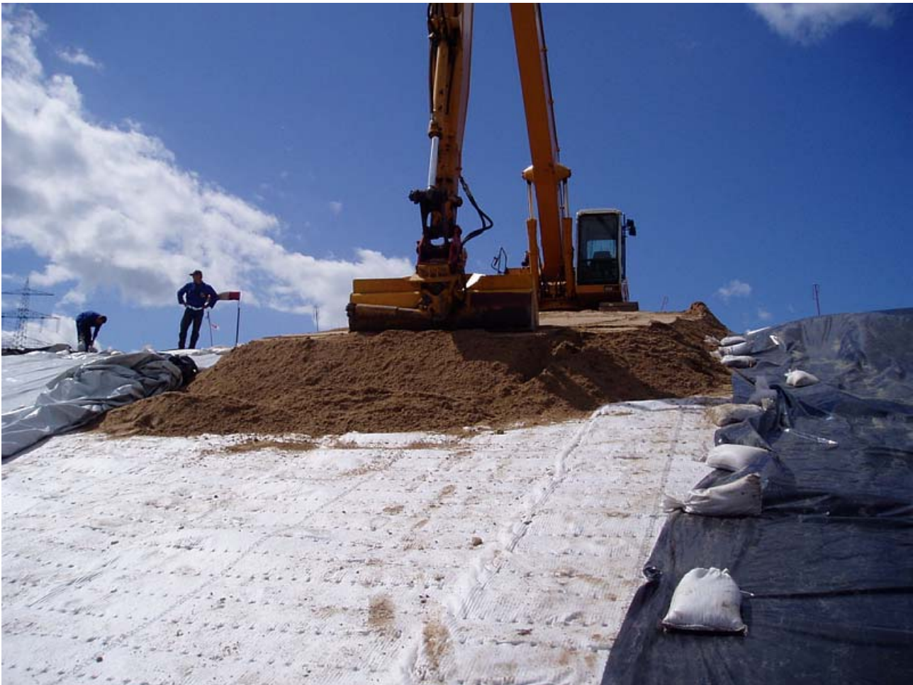
Bild 12: Einbau mineralische Drainage auf der Drainmatte
