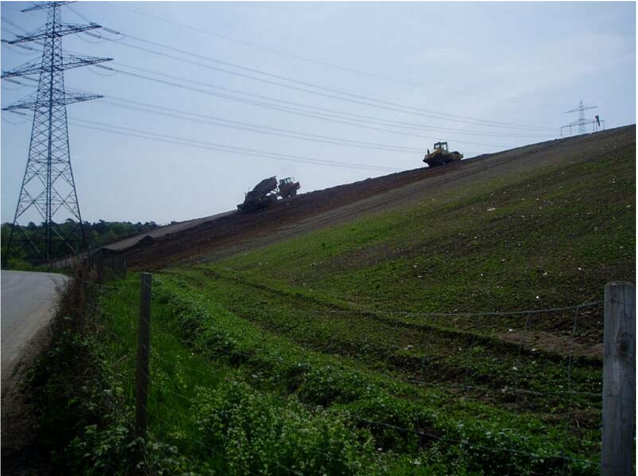
Bild 2: Lage des Testfeld mit maximale Böschungsneigung von 1:3
