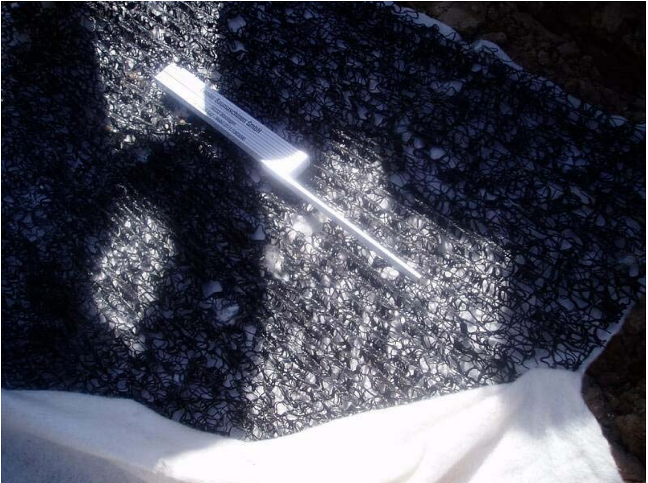
Bild 19: freigelegte Drainmatte im Bereich mit ausreichender Überdeckung
