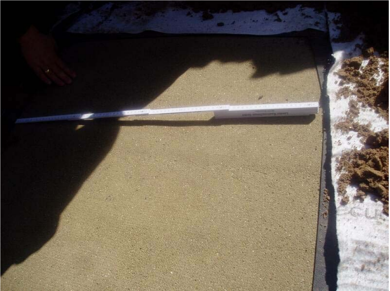
Bild 20: freigelegte Trisoplastoberfläche
