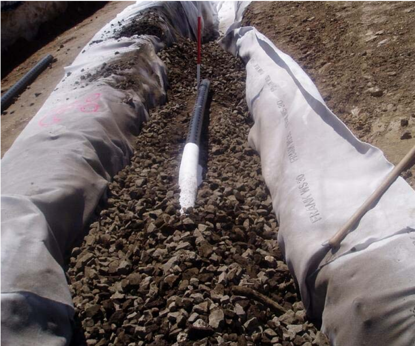
Bild 17: Graben für Horizontalkollektor am Deponierand; eingebauter Gleisschotter in Vlies eingehüllt
