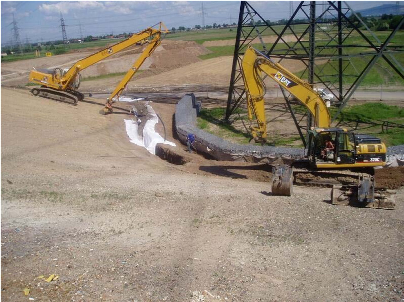
Bild 18: Bau des Horizontalkollektors im Bereich des Hochspannungsmastes
