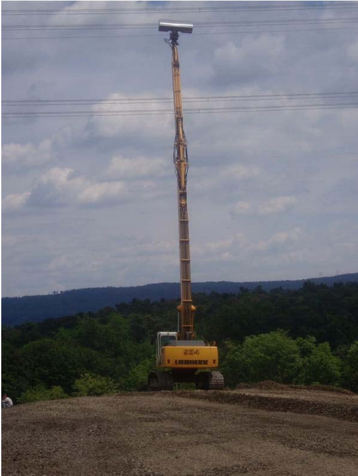
Bild 20: ausgestreckter Langarmbagger unter der 380 kV Leitung. Beim Arbeiten des Langarmbaggers unter der 380 kV Leitung war es erforderlich die Schutzabstände einzuhalten
