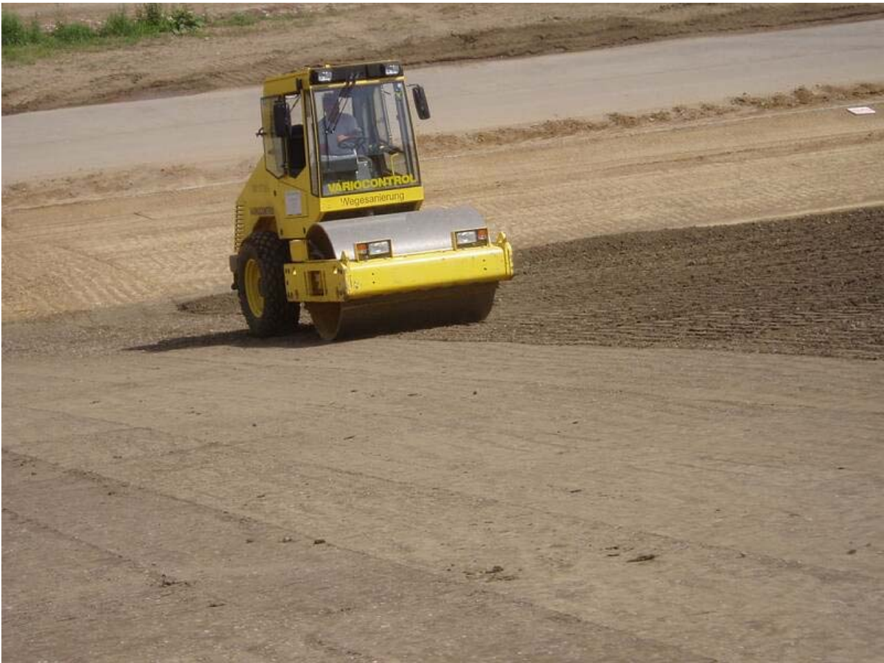
Bild 3: Verdichtung der Ausgleichsschicht über der Gasdrainschicht mit der Glattmantelwalze
