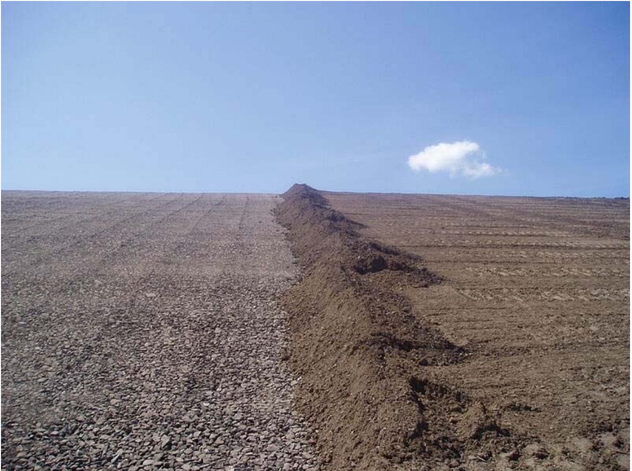
Bild 2: eingebaute Gasdrainschicht aus Gleisschotter bzw. Ausgleichsschicht 0/32 über der Gasdrainschicht
