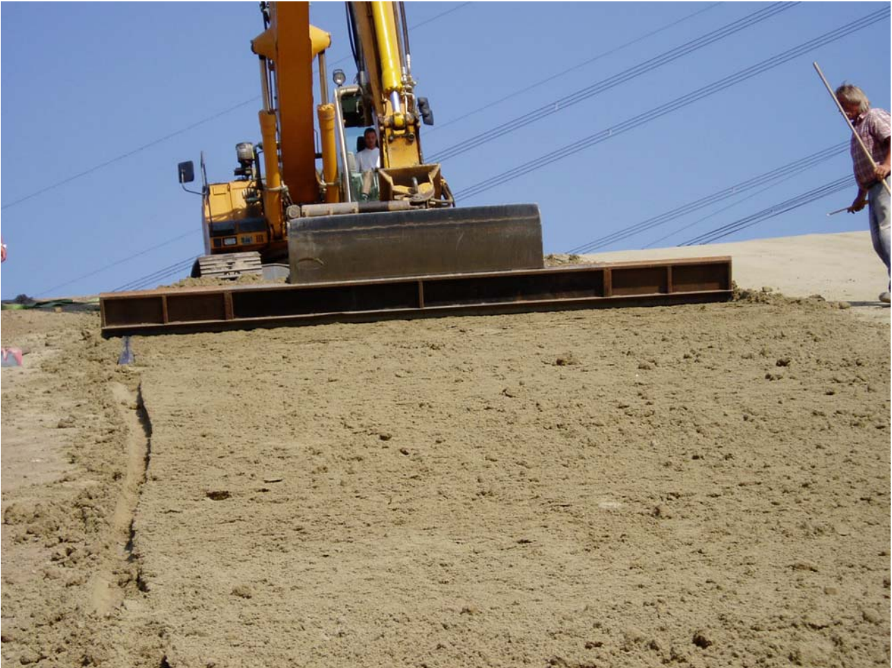
Bild 7: Abziehen der Trisoplastschicht mit dem verbreiterten Schild Schildbreite 5,0 m
