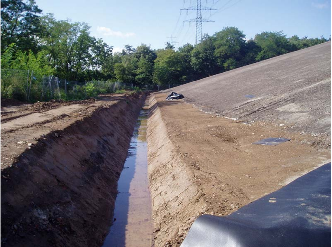
Bild 1: Am Deponierand ausgehobener Entwässerungsgraben
