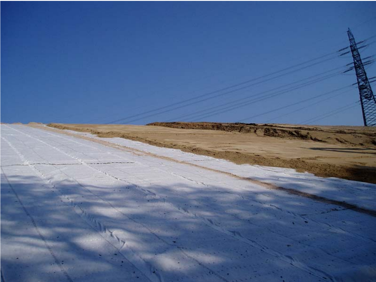
Bild 14: eingebaute Drainmatte mit aufgebracht Kies-Sandschicht zur Entwässerung
