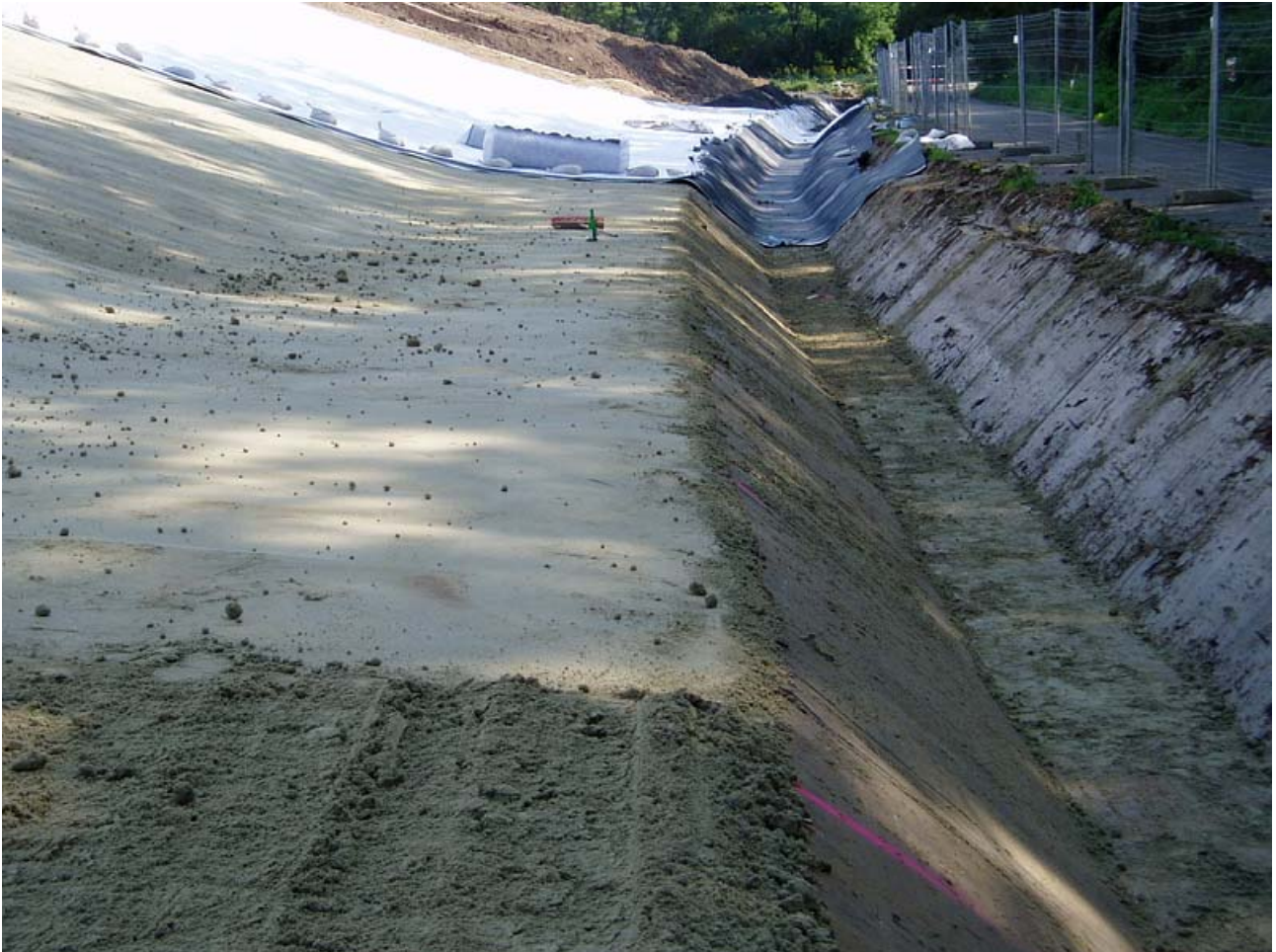
Bild 19: Randgraben am südlichen Deponierand
