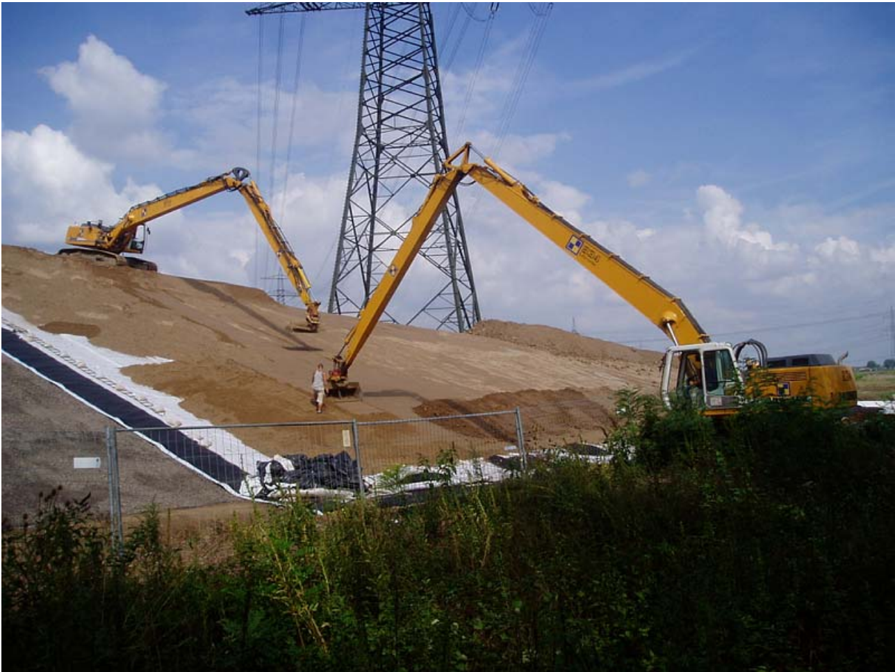
Bild 13: Abziehen der mineralischen Drainage mit dem Baggerschild
