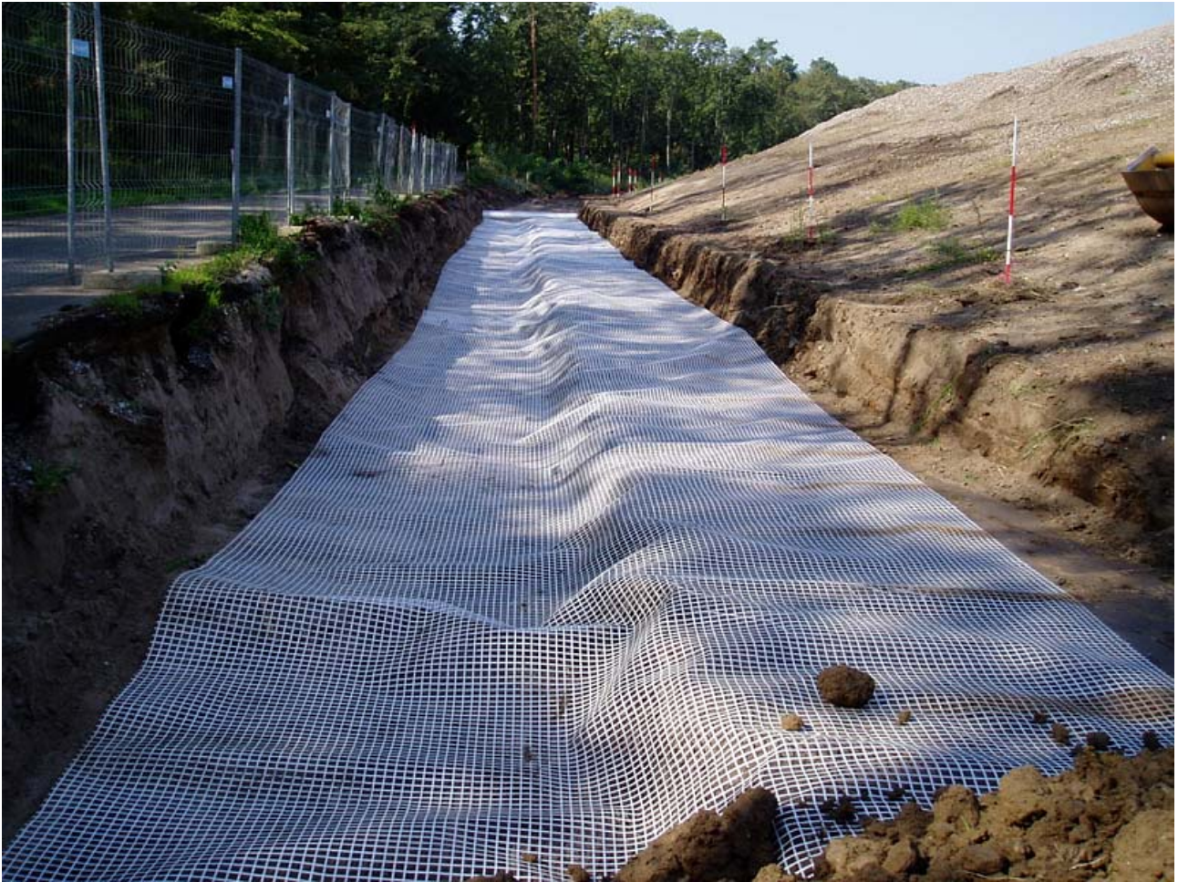
Bild 18: Verlegen von Geogitter am Deponierand im Bereich des mineralischen Dichtungskeiles
