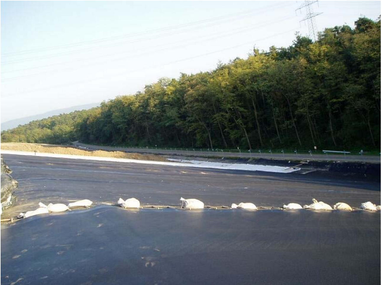
Bild 7: eingebaute PE-HD Dichtungsbahn im Bereich der Südböschung im Ostteil der Deponie
