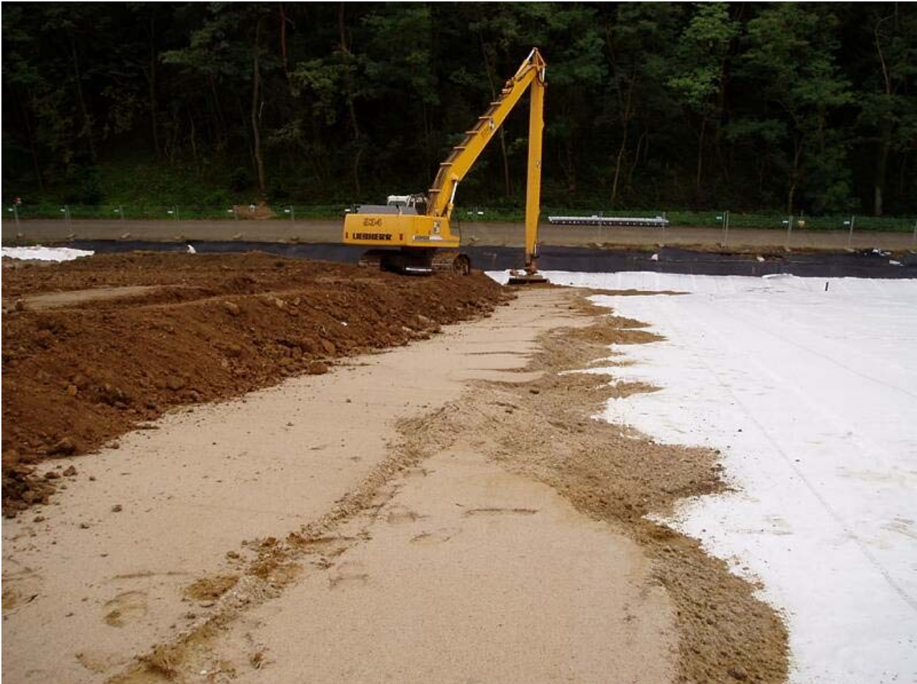
Bild 16: eingebaute Rekultivierungsschicht über der mineralischen Drainage
