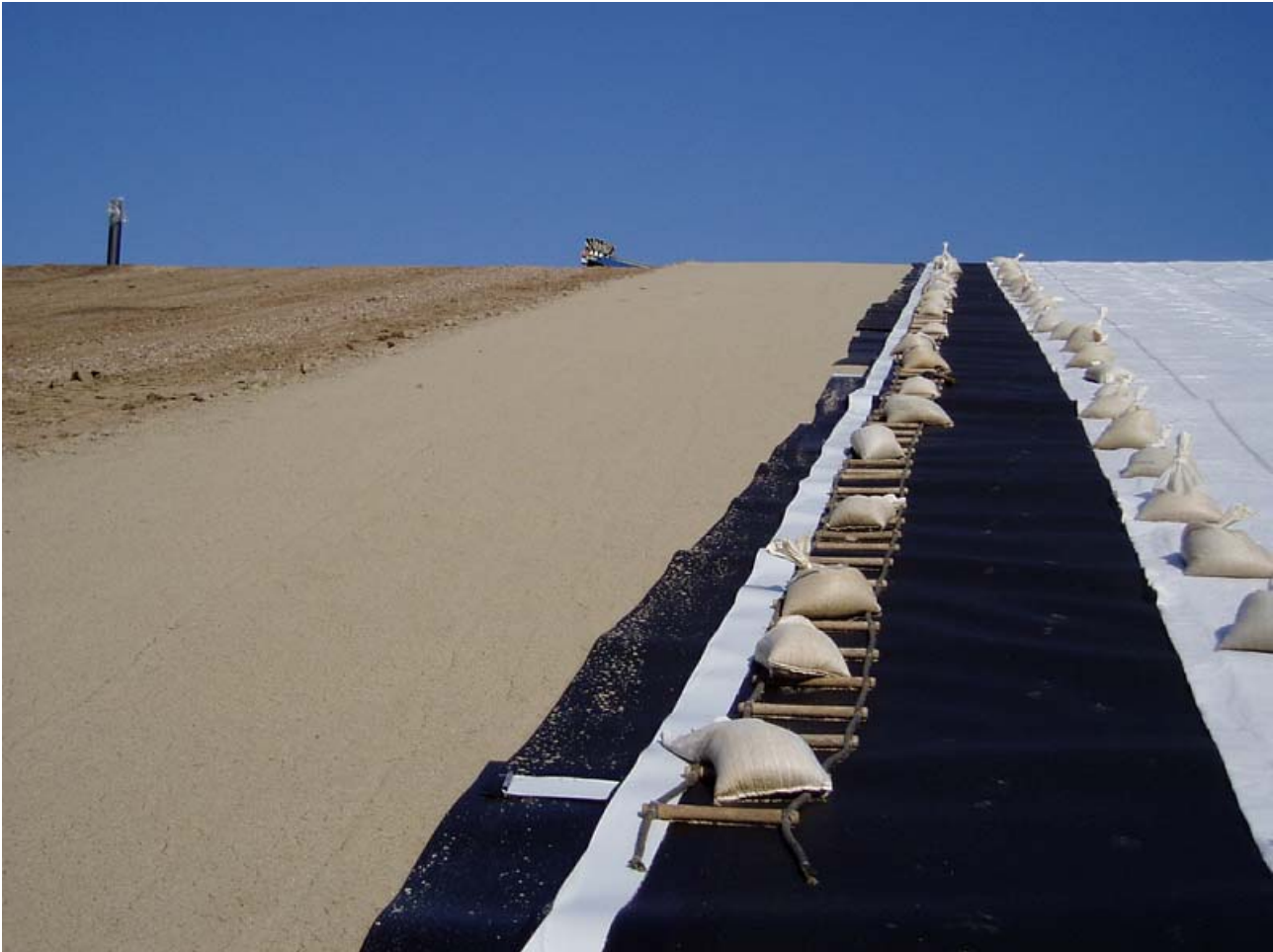
Bild 6: eingebautes Trisoplast und KDB und Drainmatte
