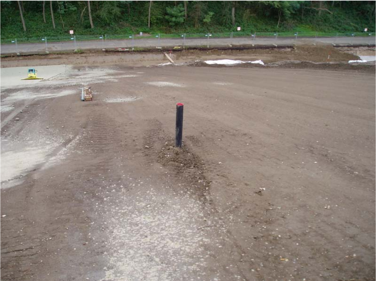
Bild 2: eingebaute Schutzschicht 0/32 teilweise abgewalzt
