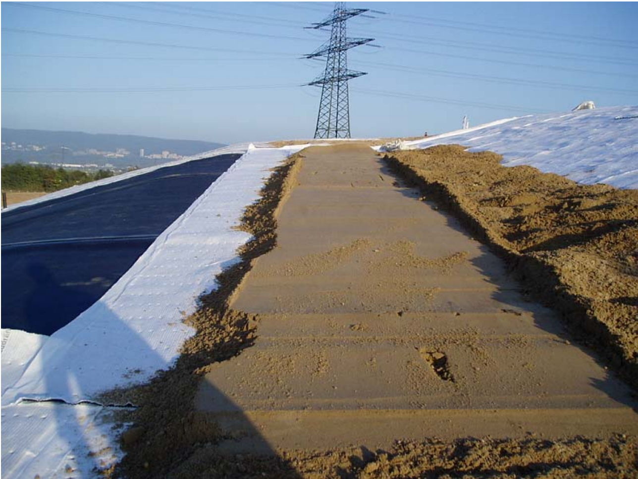
Bild 12: Abziehen der mineralischen Drainage 0/63 mit dem Baggerschild
