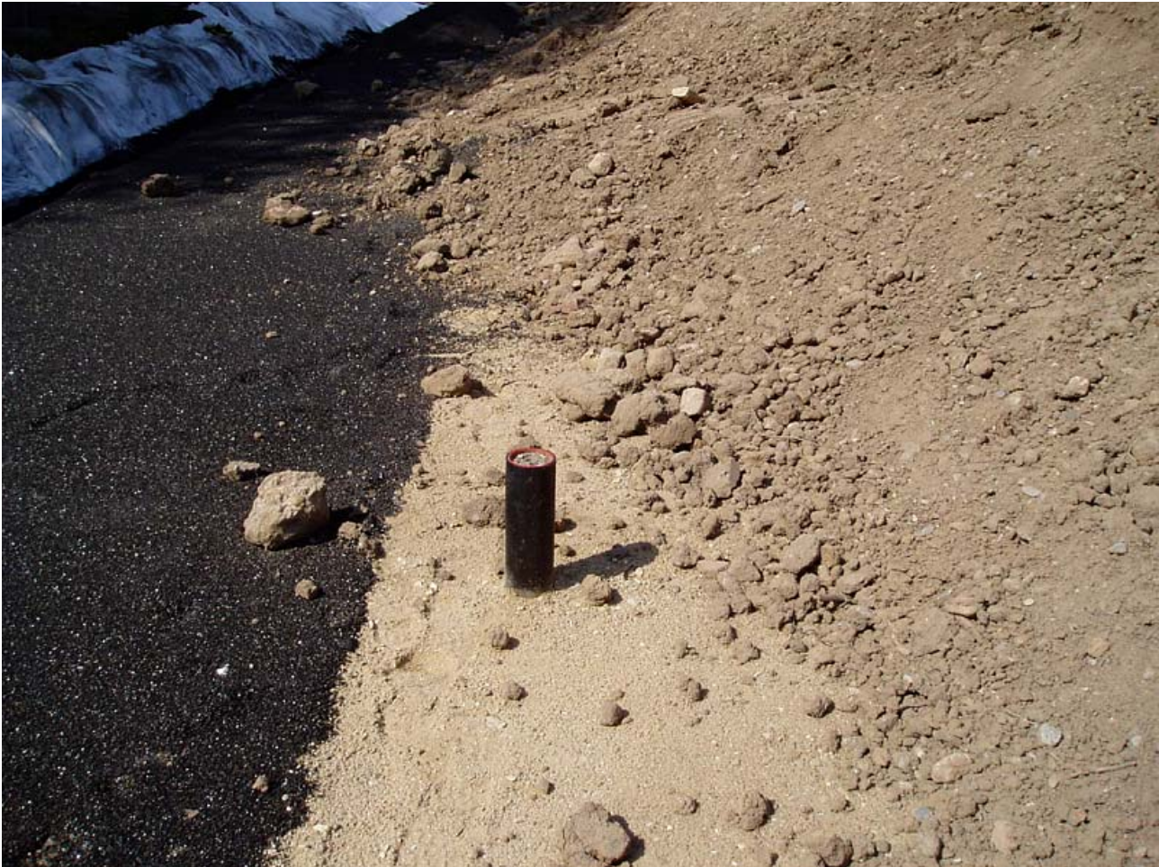
Bild 15: eingebautes Schmelzkammergranulat 0/8 am Böschungsfuß
