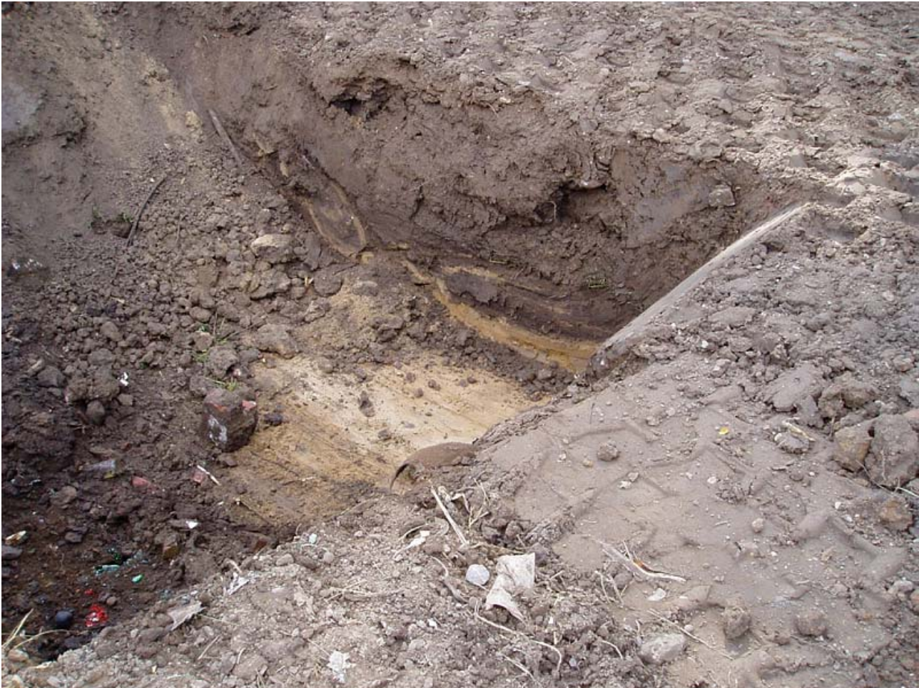
Bild 17: Suchschlitz am Deponierand zur Ermittlung der Deponiegrenze
