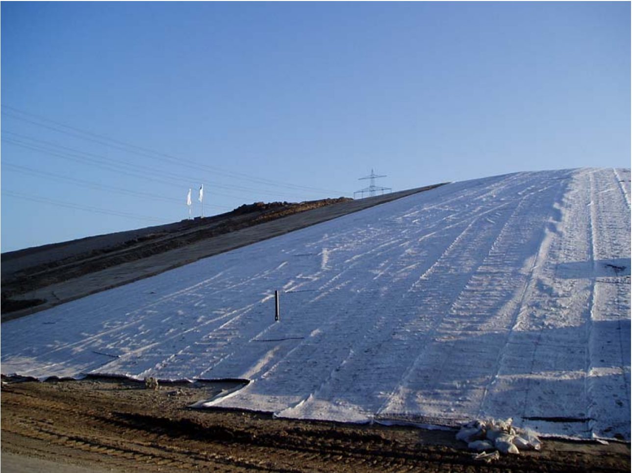
Bild 9: eingebaute Drainmatte im Bereich des Nordrandes im Ostteil der Deponie
