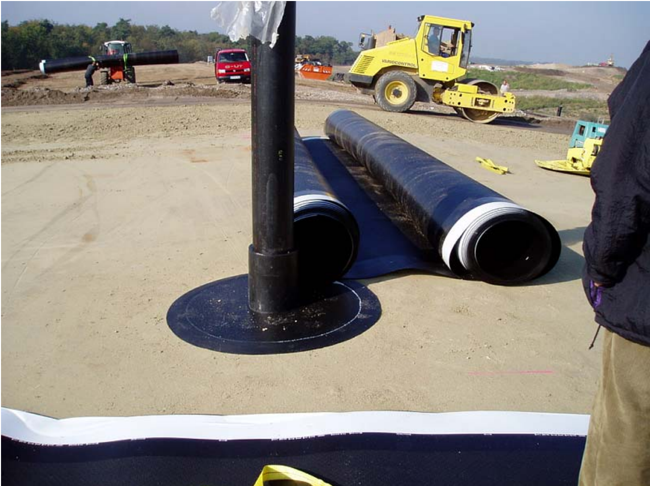
Bild 8: PE-HD Dichtungskragen im Bereich der Durchdringungen für die Gasbrunnen im Ostteil
