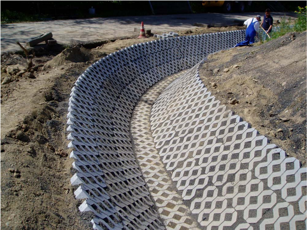
Bild 22: Verlegte Rasengittersteine im Bereich des Randgrabens an der Südostecke
