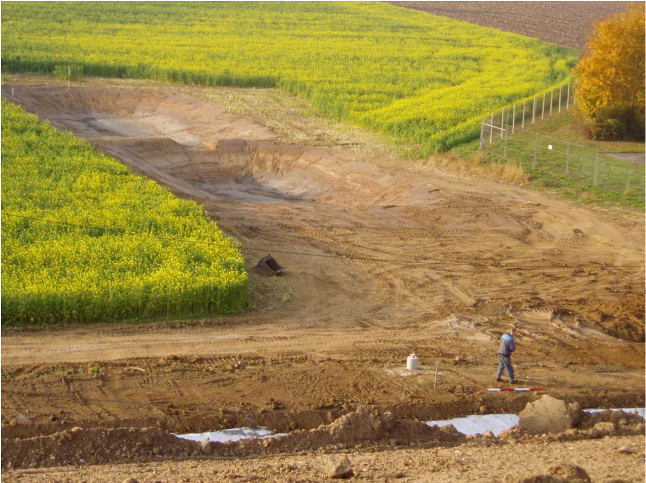
Bild 24: temporäres Absetz- und Versickerungsbecken am Westrand der Deponie
