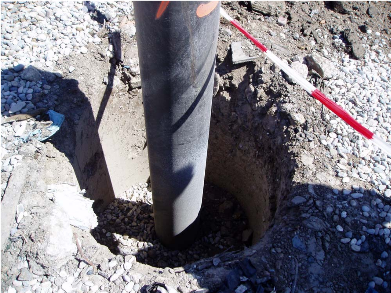
Bild 2: ausgebauter Gasbrunnen mit Kiesfilter
