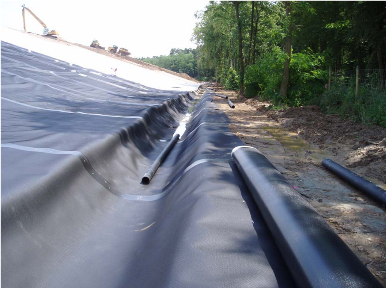
Bild 21: In dem Randgraben verlegte Kunststoffdichtungsbahn
