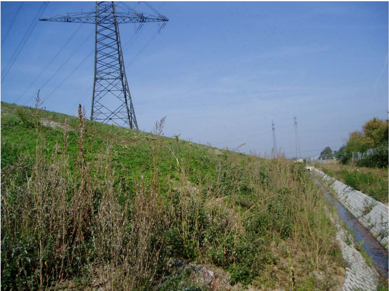
Bild 17: eingebaute Rekultivierungsschicht mit aufgegangener Begrünung am Ostrand der Deponie
