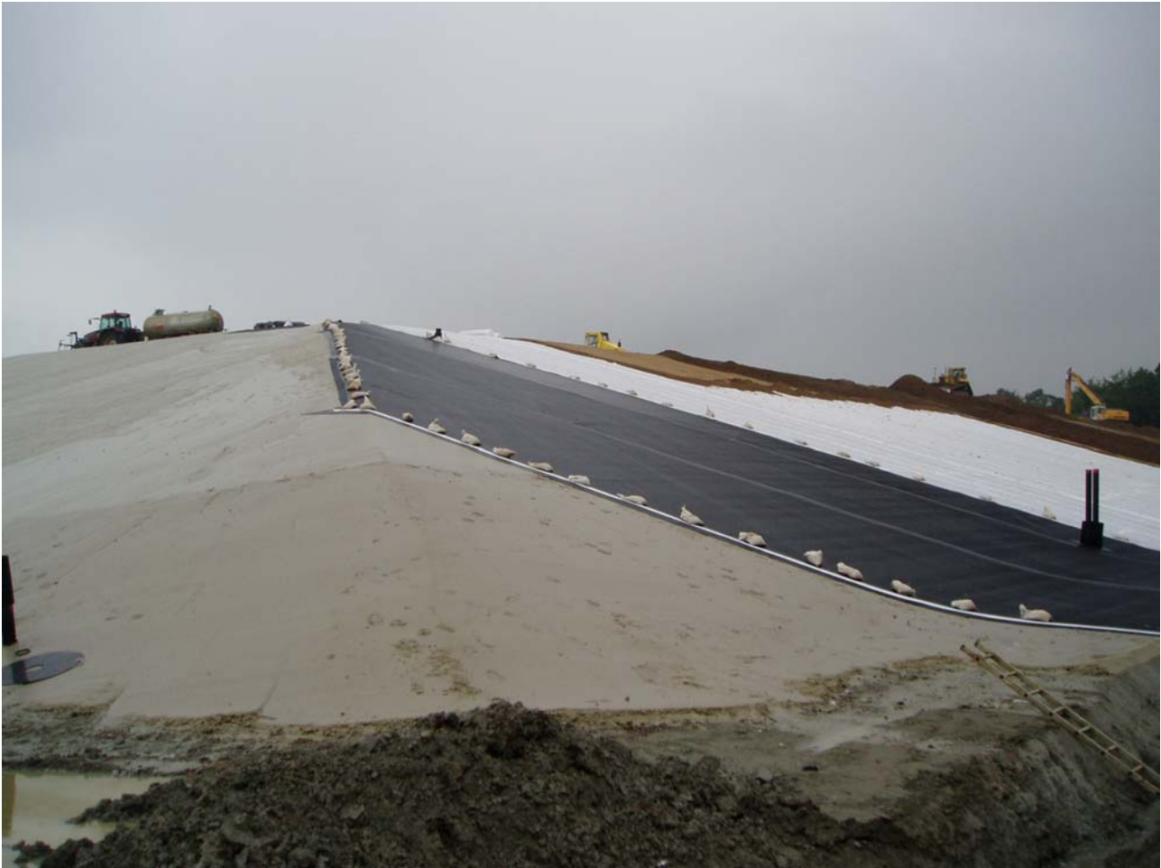
Bild 10: Blick auf die Nordwestecke der Deponie mit Darstellung des gesamten Dichtungssystems
