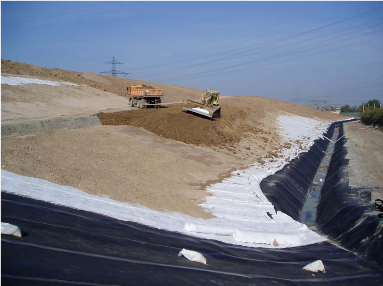
Bild 15: Einbau des Rekultivierungsmaterials vom Deponieweg aus mit der Raupe
