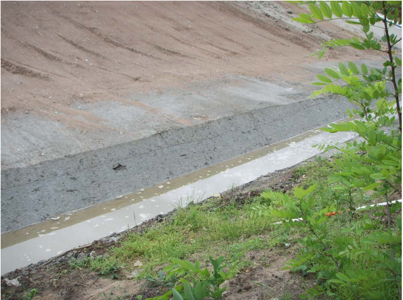
Bild 20: Randgraben nach einem Regenereignis
