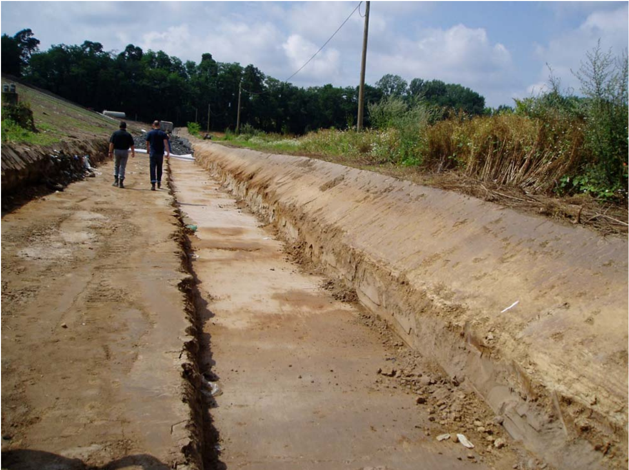
Bild 19: Aushub des mineralischen Dichtungskeiles am Westrand der Deponie
