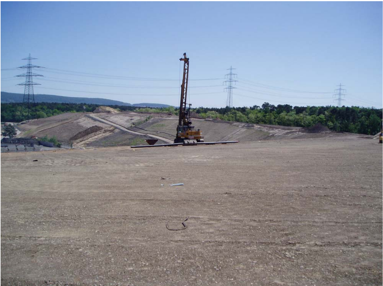
Bild 8: Blick vom Westteil der Deponie Richtung Ostteil, OK Profilierung bzw. OK Ausgleichsschicht
