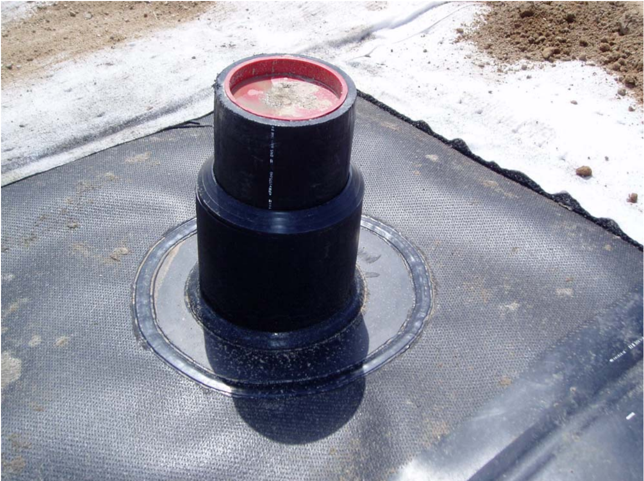
Bild 3: Durchdringung Gasbrunnen durch die PE-HD Dichtungsbahn
