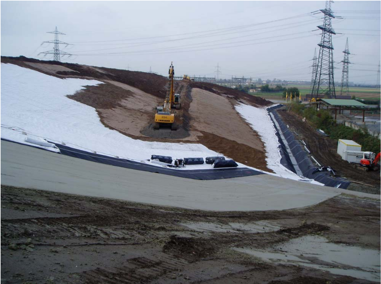
Bild 14: Dichtungs- und Wegebau in Bereich der Ostböschung Richtung KAM
