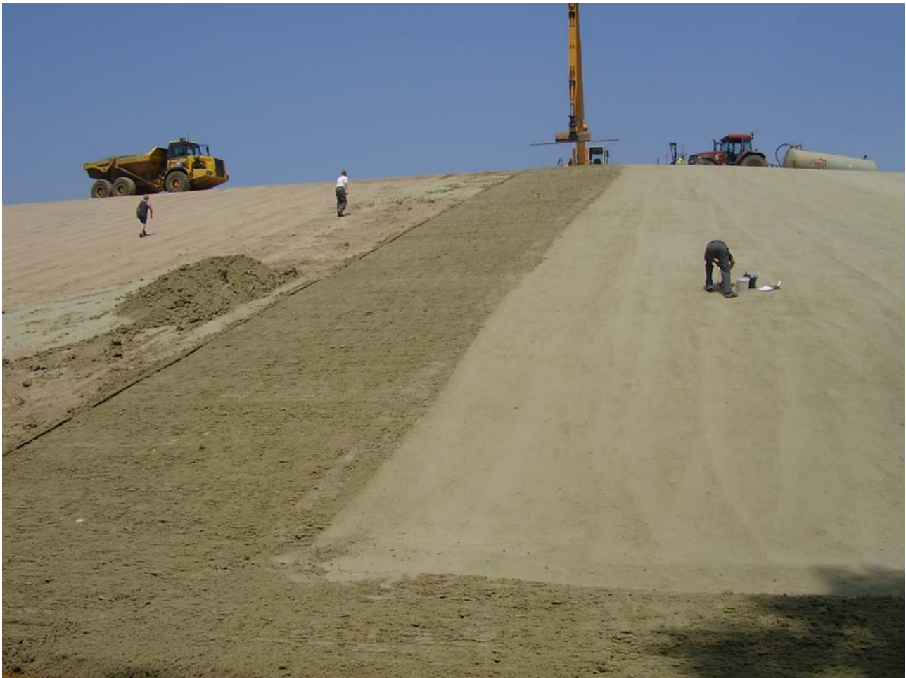
Bild 9: Trisoplasteinbau im Bereich der Südböschung
