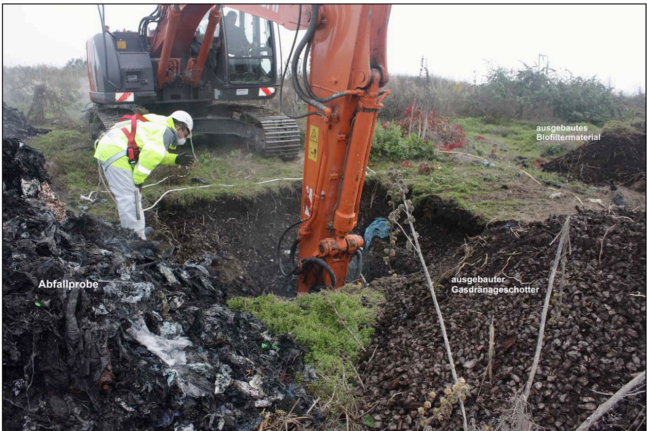
Abbildung 2 Übersicht über die Baggerarbeiten
