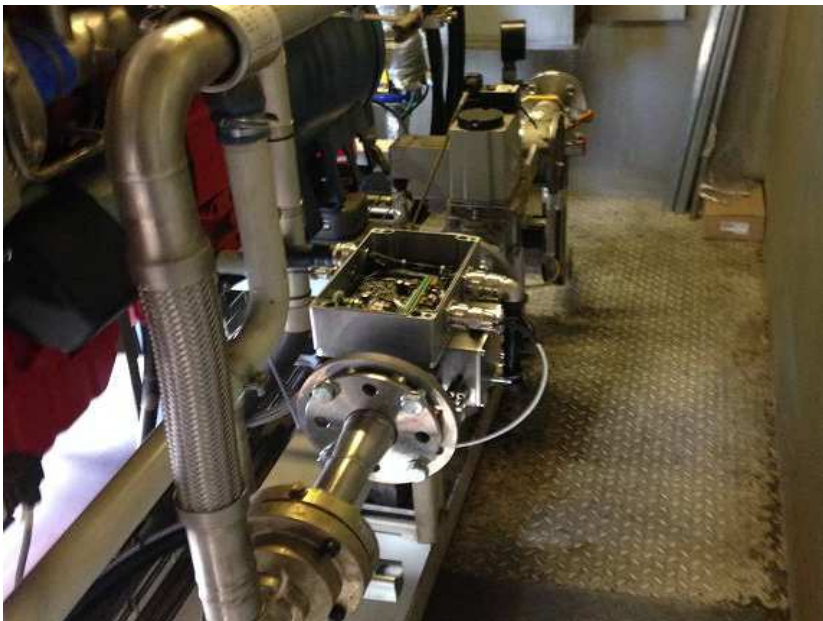
Abbildung 4: Gasmischer nach dem Umbau
