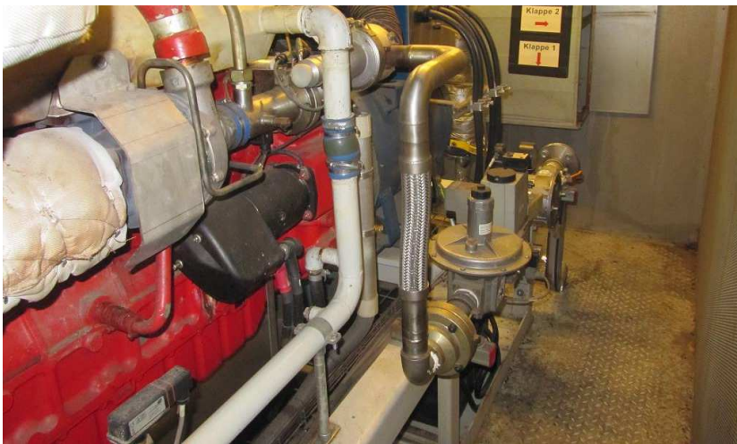
Abbildung 3: Gasmischer vor dem Umbau
