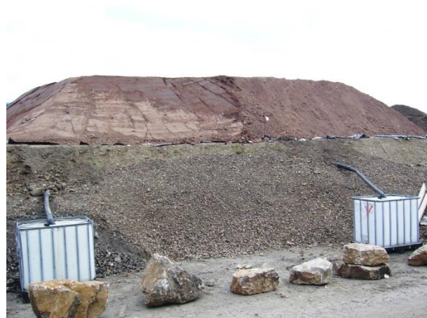
Abbildung 3: Errichtung der beiden Lysimeter 2009
