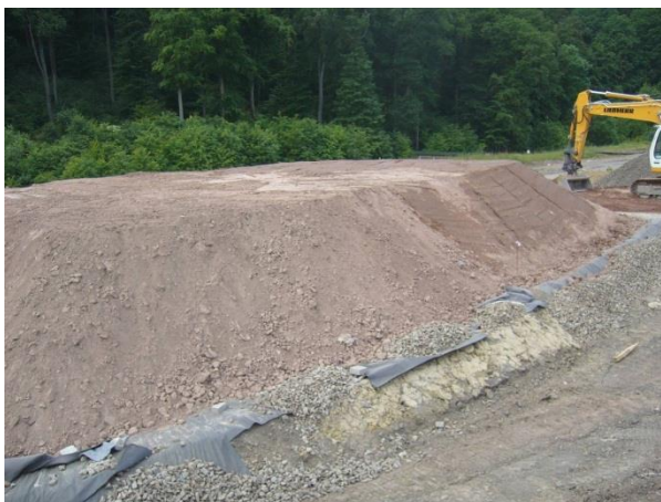
Abbildung 3: Errichtung der beiden Lysimeter 2009
